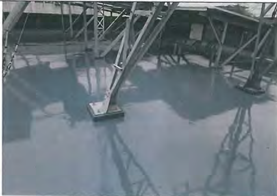
辦公廳舍屋頂防水 PU 面漆施工後
