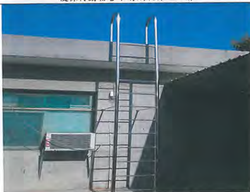
後棟待勤宿舍不銹鋼爬梯施工後
