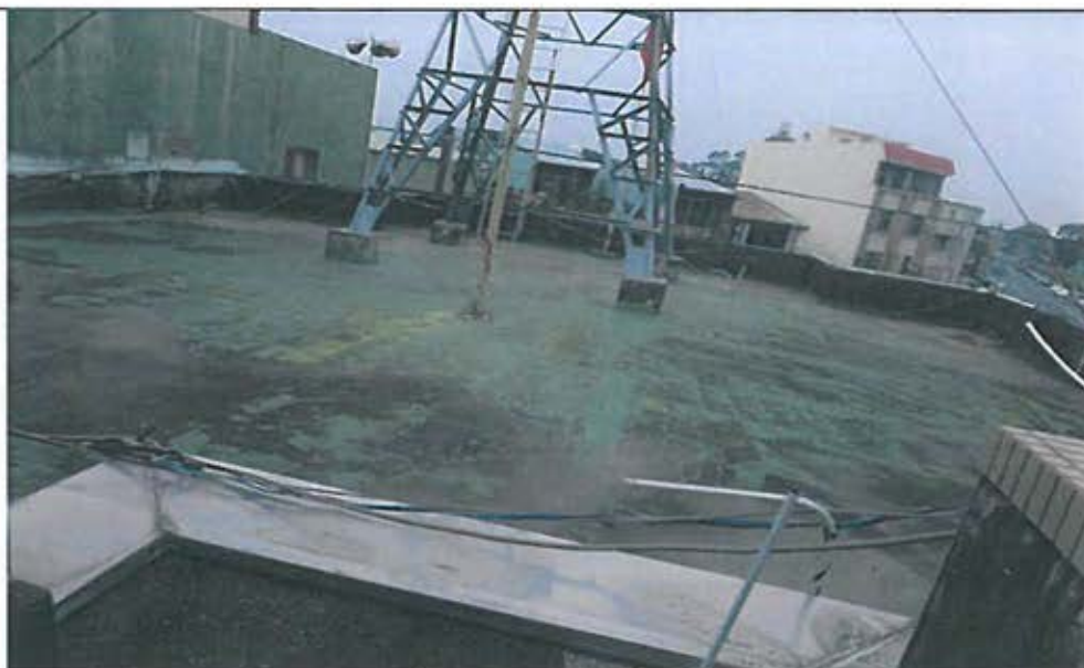
辦公廳舍屋頂防水 PU 施工前
