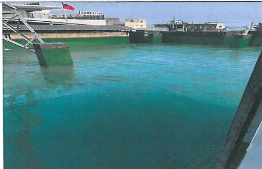
辦公廳舍屋頂地面防水 PU 底漆施工
