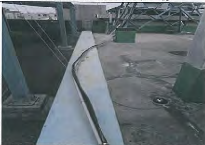
辦公廳舍屋頂伸縮鋼板更新施工前
