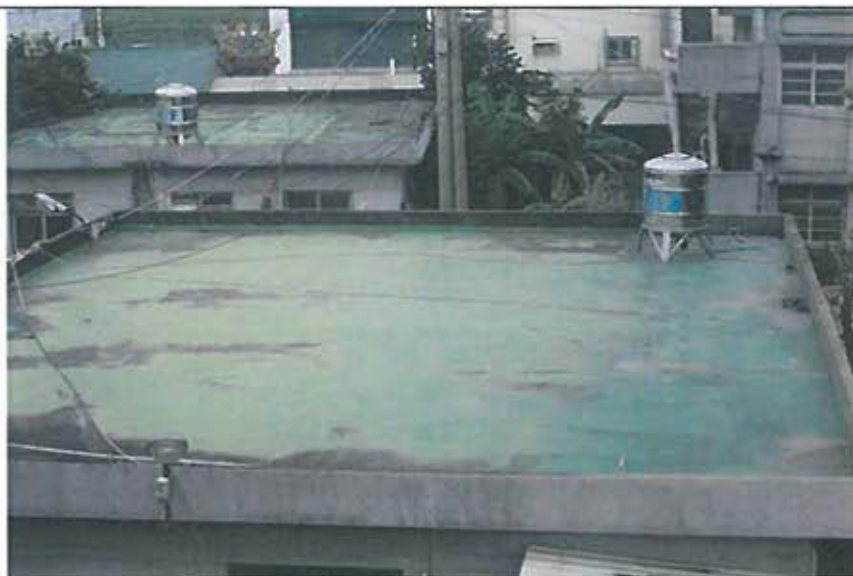
後棟待勤宿舍屋頂地面防水 PU 施工前
