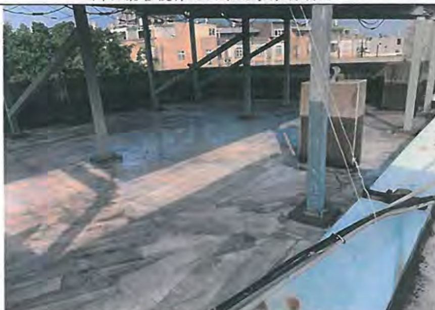
增建辦公廳舍屋頂防水 PU 底漆施工
