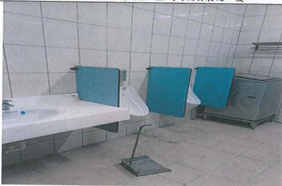
2樓盥洗室洗手台、小便斗、搗擺安裝施工後
