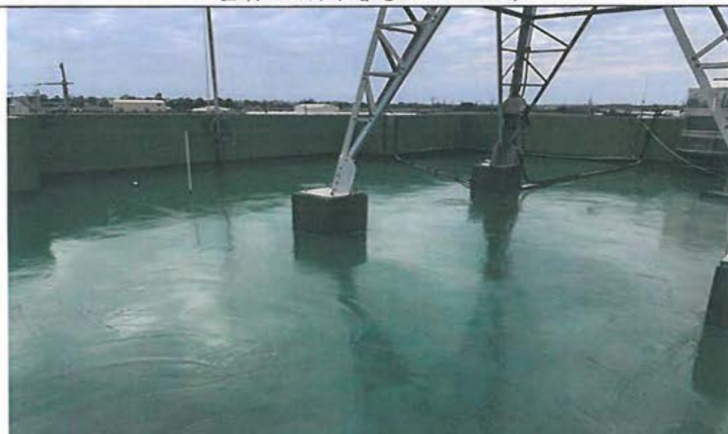
屋頂地面研磨清潔施工
