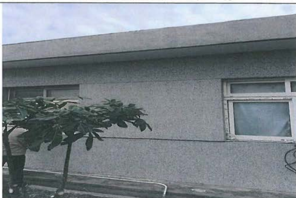
待勤宿舍不銹鋼爬梯施工前
