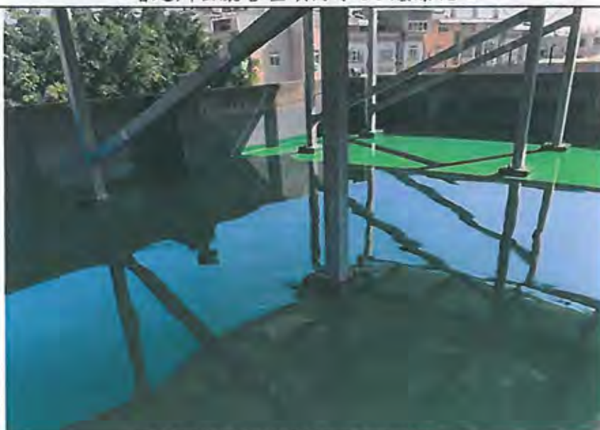
增建辦公廳舍屋頂防水 PU 中才施工
