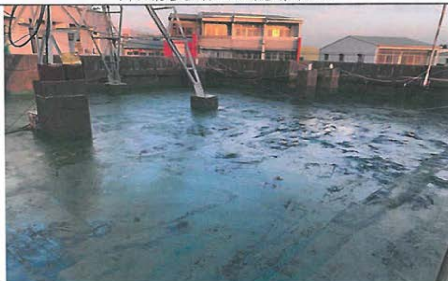
辦公廳舍屋頂防水 PU 底漆施工
