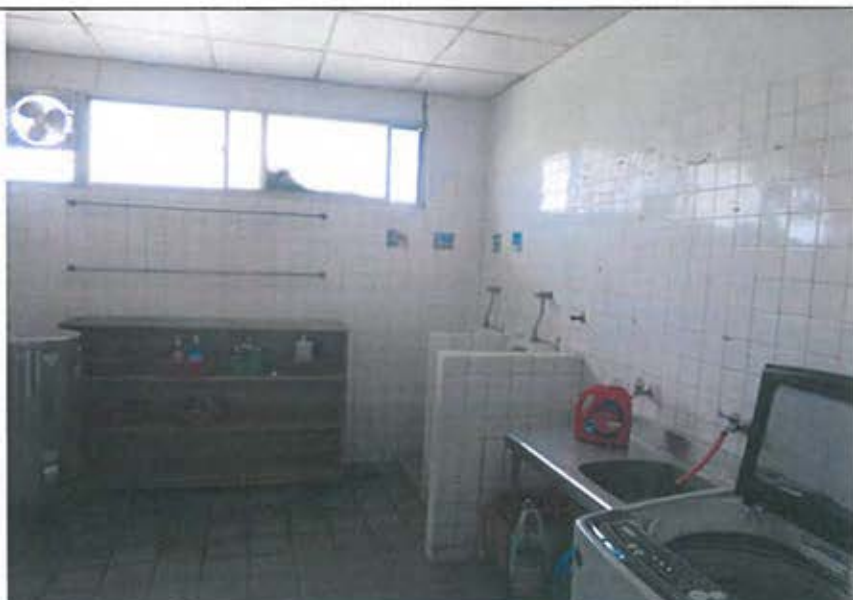
2樓盥洗室整修施工前
