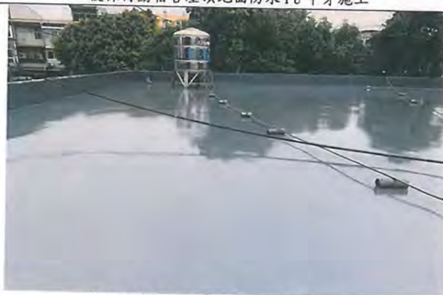
後棟待勤宿舍屋頂地面防水 PU 面漆施工
