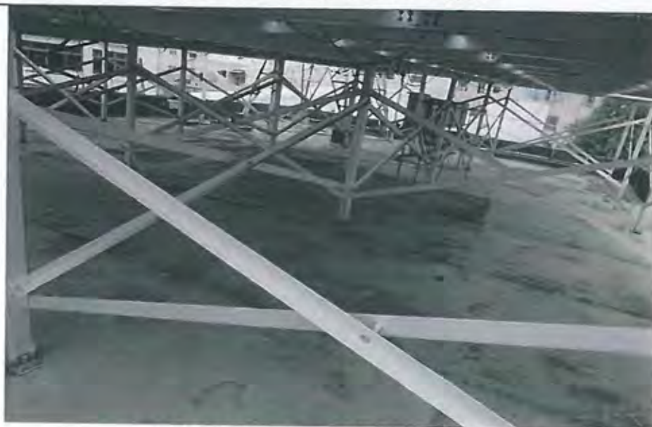
北側辦公廳舍屋頂施作防水 PU 施工前
