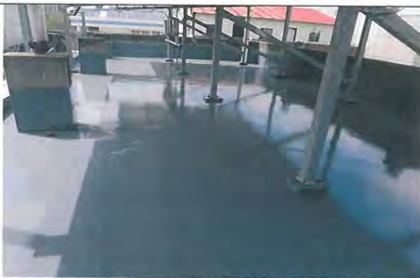
增建辦公廳舍屋頂防水 PU 面漆施工後
