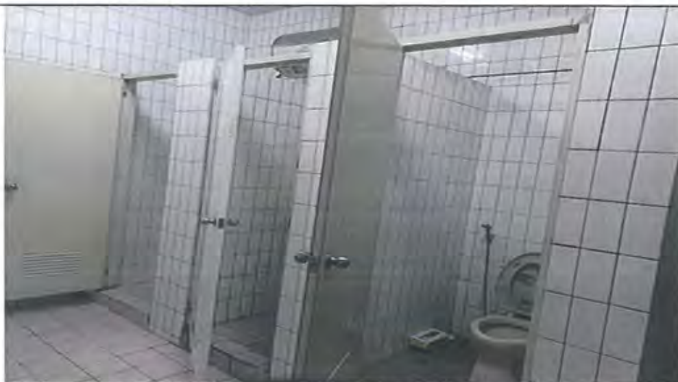
3樓待勤盥洗室地面磁磚重新鋪設及盥洗設備汰換施工前
