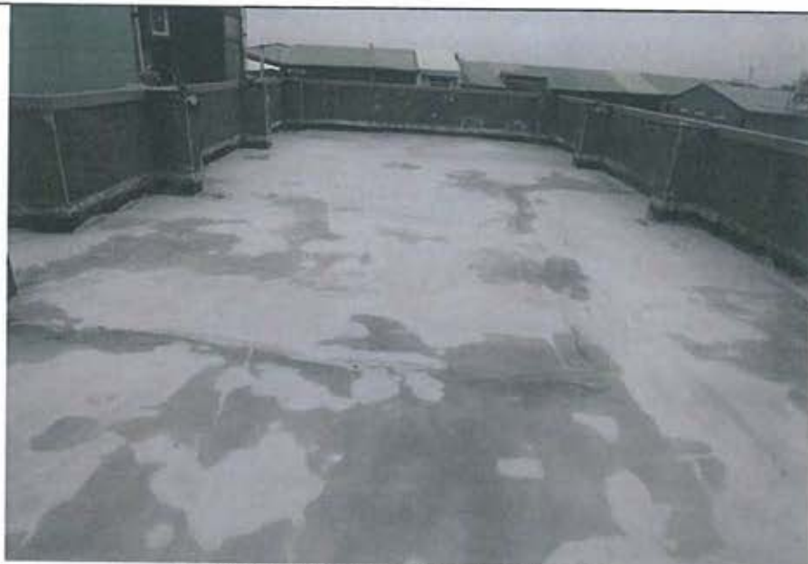
增建辦公廳舍地面水泥砂漿粉刷施工
