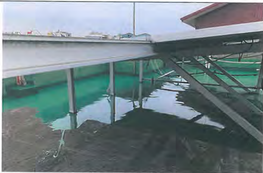
辦公廳舍屋頂防水 PU 中才施工
