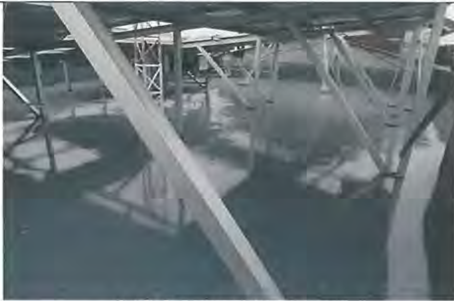
辦公廳舍屋頂防水 PU 面漆施工後
