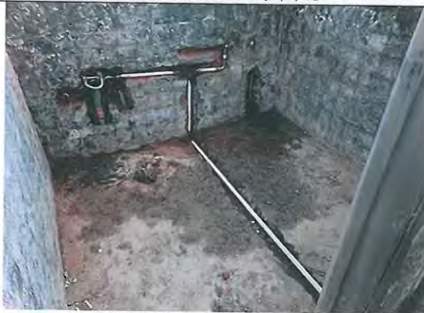
2樓盥洗室給排水管路打鑿埋設施工
