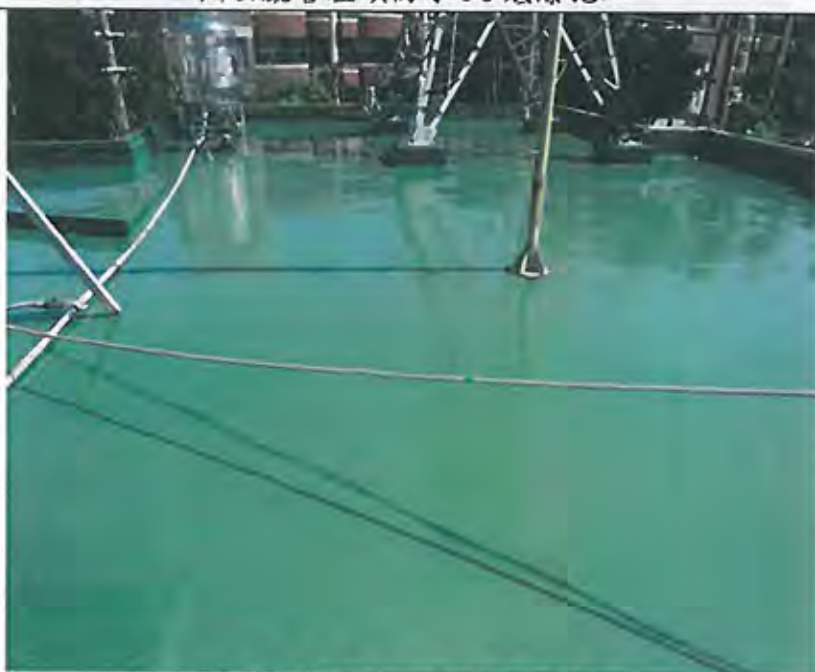
辦公廳舍屋頂防水PU中才施工
