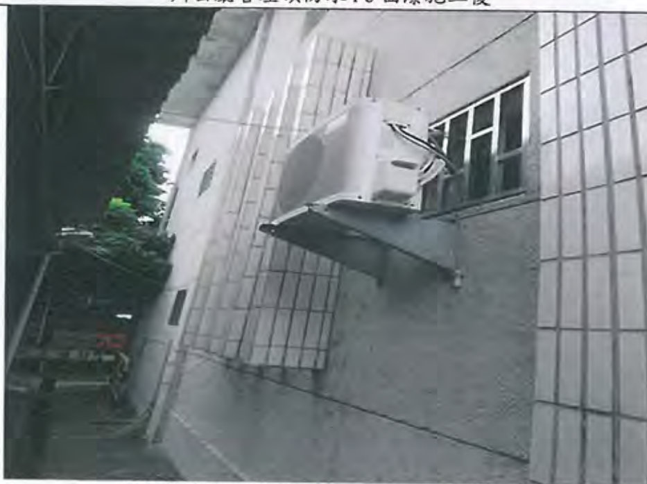
辦公廳舍南側牆壁釘封複合金屬壁板施工前
