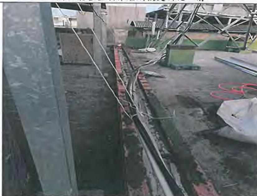
辦公廳舍屋頂伸縮砌紅磚施工
