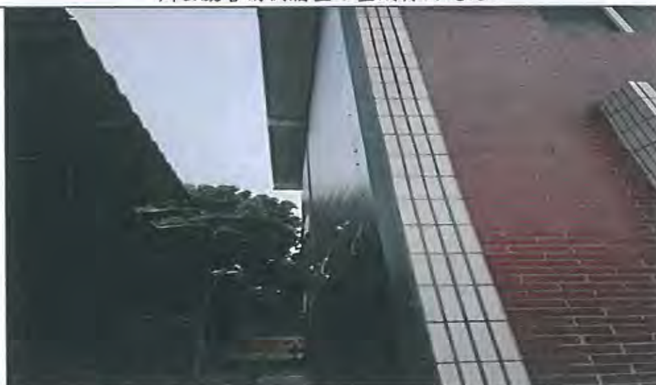
南側辦公廳舍南側牆壁釘封複合金屬壁板施工後
