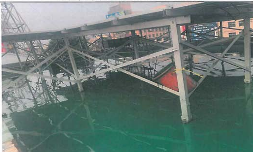
北側辦公廳舍屋頂防水 PU 中材施工
