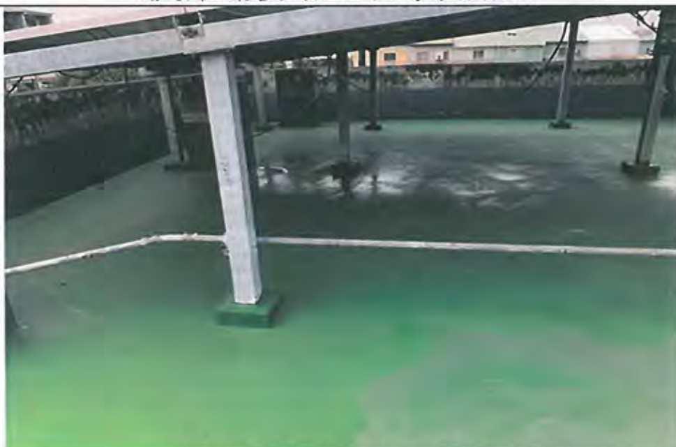
增建辦公廳舍屋頂防水 PU 面漆施工
