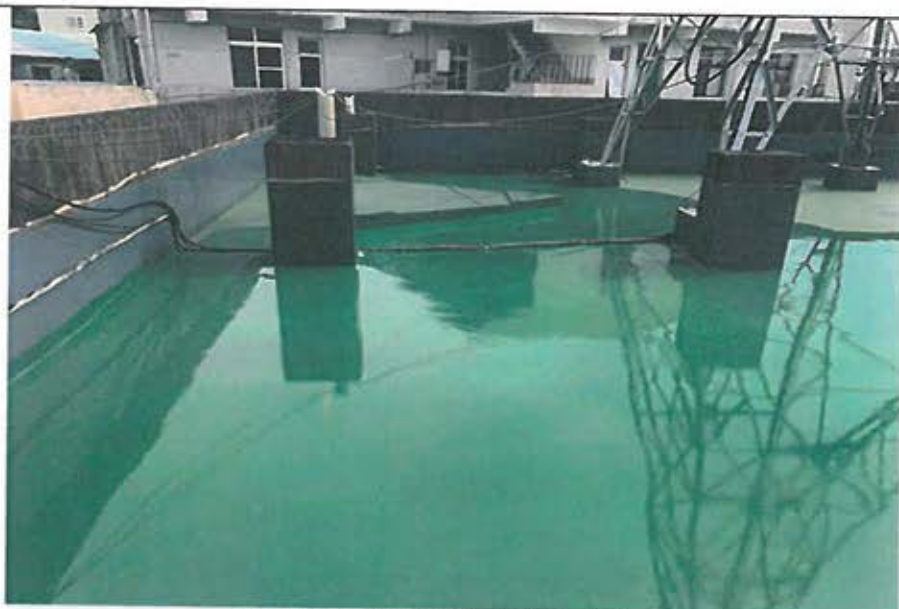
辦公廳舍屋頂防水 PU 中才施工
