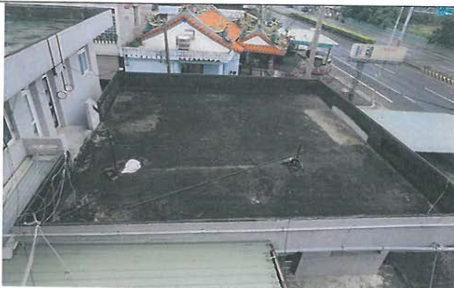
前棟待勤宿舍屋頂防水 PU 施工前
