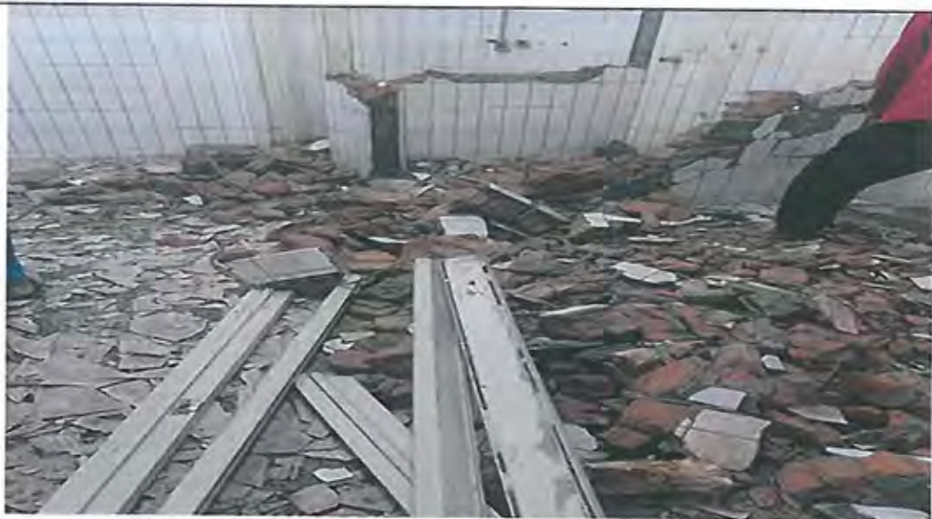
3樓待勤盥洗室磚造隔間及牆壁地面磁磚拆除施工
