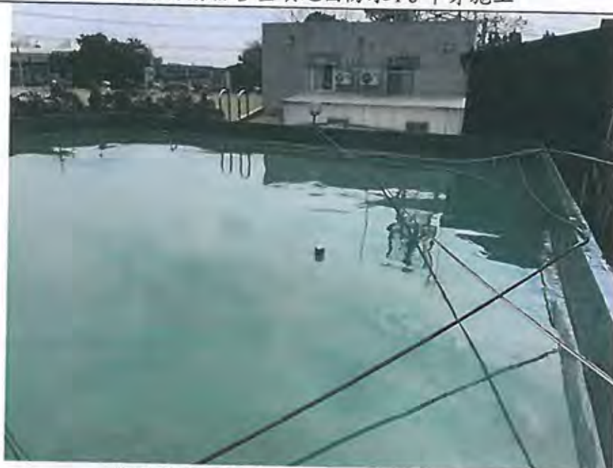
後棟待勤宿舍屋頂地面防水 PU 中才施工
