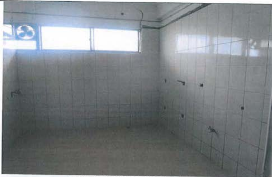
2樓盥洗室牆壁地面鋪貼磁磚施工
