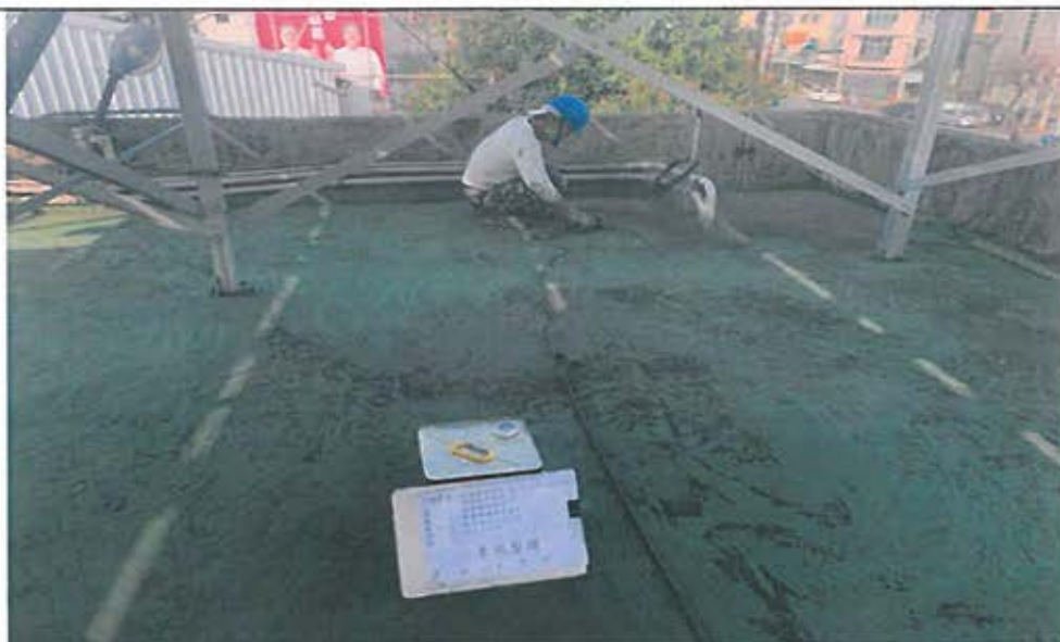
北側辦公廳舍屋頂地面研磨清潔施工
