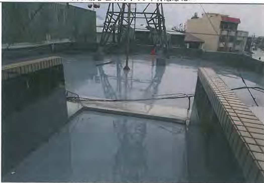
辦公廳舍屋頂防水 PU 面漆施工後
