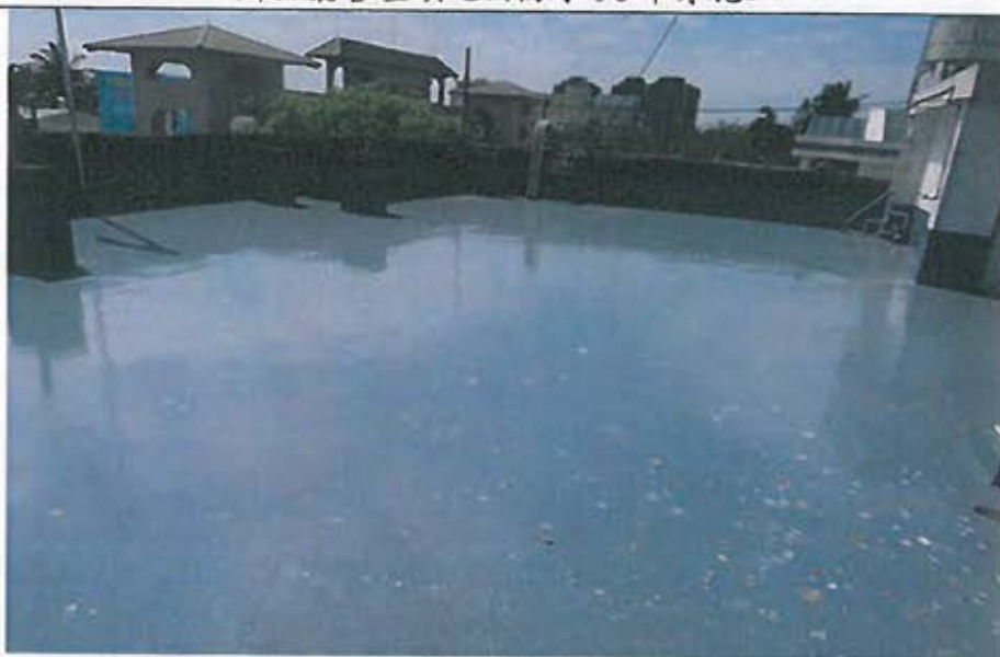
辦公廳舍屋頂地面施作防水 PU 面漆施工後
