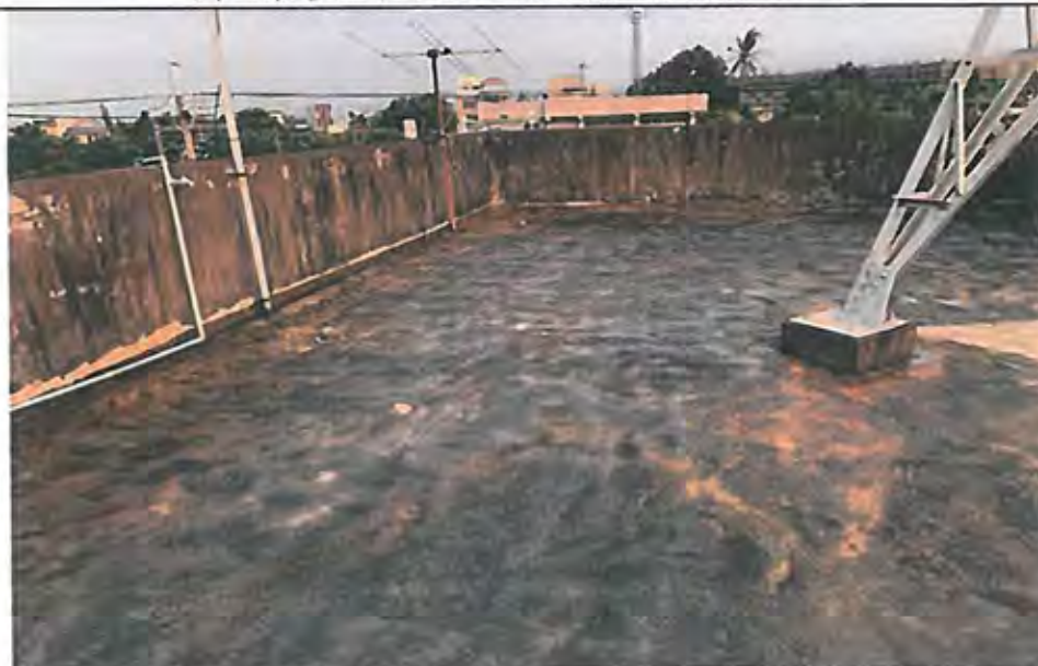
辦公廳舍屋頂水泥地面防水 PU 底漆施工
