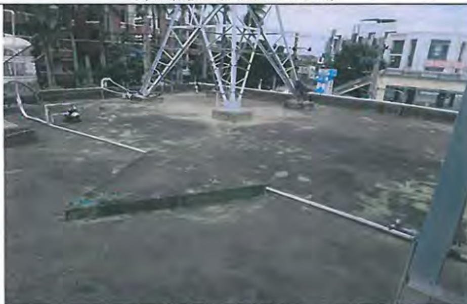
辦公廳舍屋頂防水 PU 施工前
