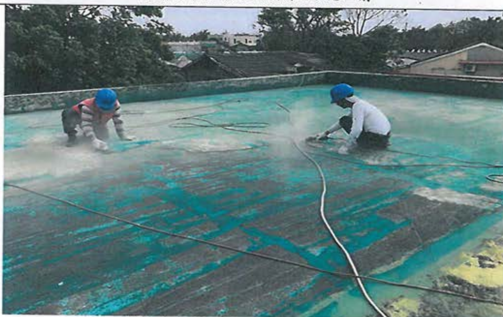
待勤宿舍屋頂地面污穢研磨清潔施工
