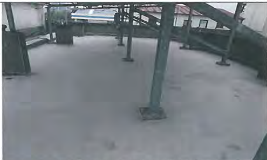
辦公廳舍後棟地面水泥砂漿粉刷施工
