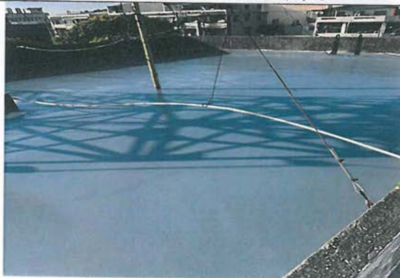
前棟待勤宿舍屋頂地面防水 PU 面漆施工後
