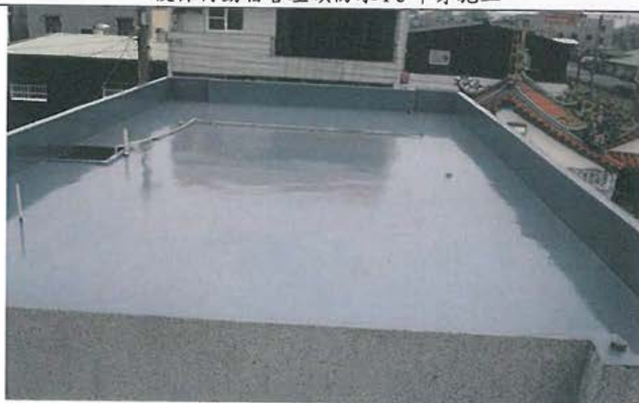
後棟待勤宿舍屋頂防水 PU 施工後
