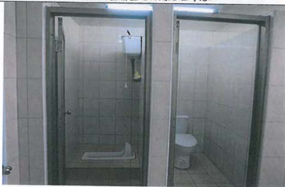
2樓盥洗室廁所蹲式便斗及座式馬桶安裝施工後
