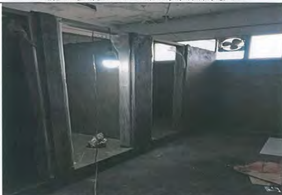
2樓盥洗室牆壁地面防水塗刷施工
