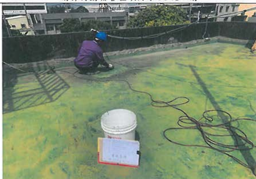
前棟待勤宿舍屋頂地面污穢研磨清潔施工
