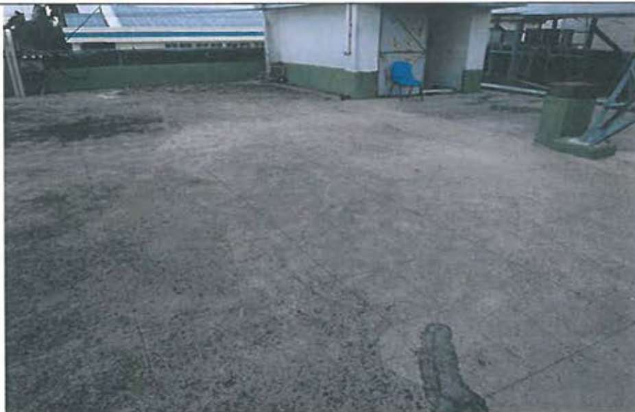
辦公廳舍屋頂施作防水 PU 施工前
