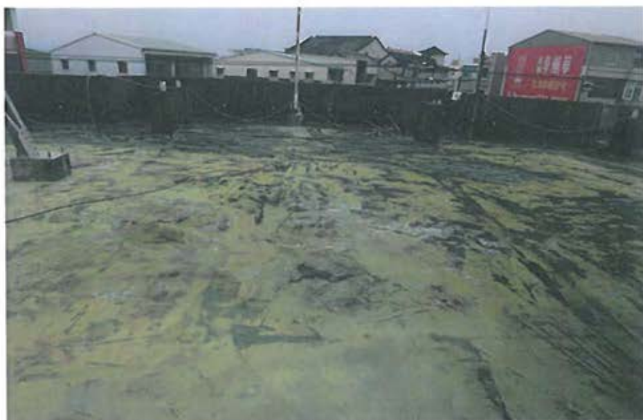
辦公廳舍屋頂防水 PU 面漆施工前
