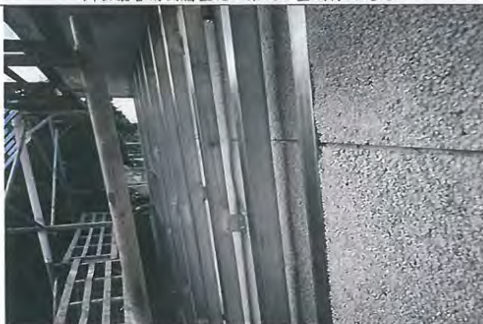
辦公廳舍南側牆壁 C 型鋼材固定施工
