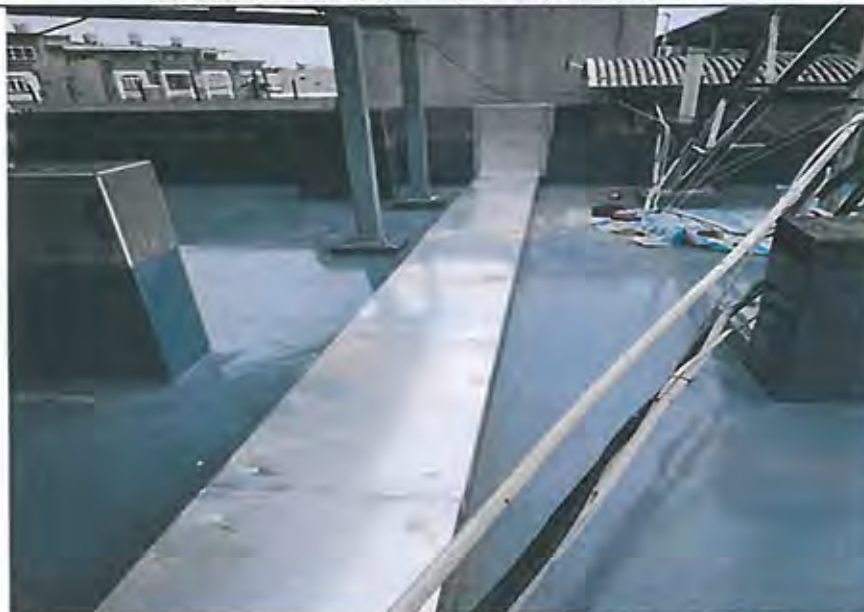
辦公廳舍屋頂伸縮縫更換門型不銹鋼板固定施工後
