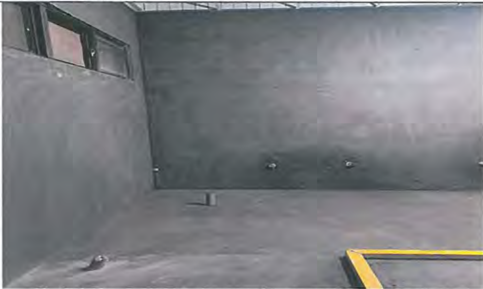
3樓待勤鹽洗室牆壁地面1：3水泥砂漿打底粉刷施工
