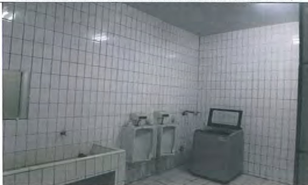
3樓待勤盥洗室地面磁磚重新鋪設及盥洗設備汰換施工前
