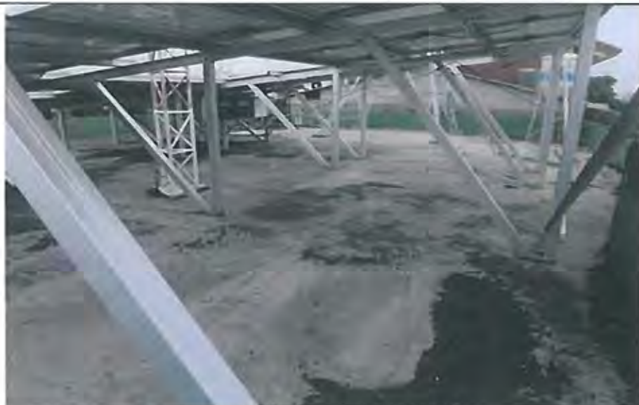
辦公廳舍屋頂防水 PU 施工前
