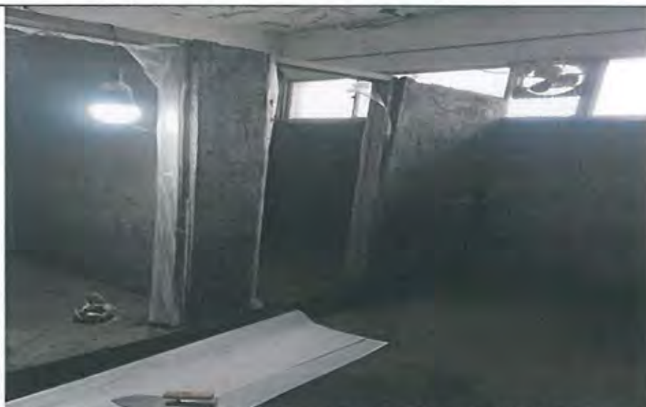
2樓盥洗室牆壁地面1：3水泥砂漿粉刷打底施工
