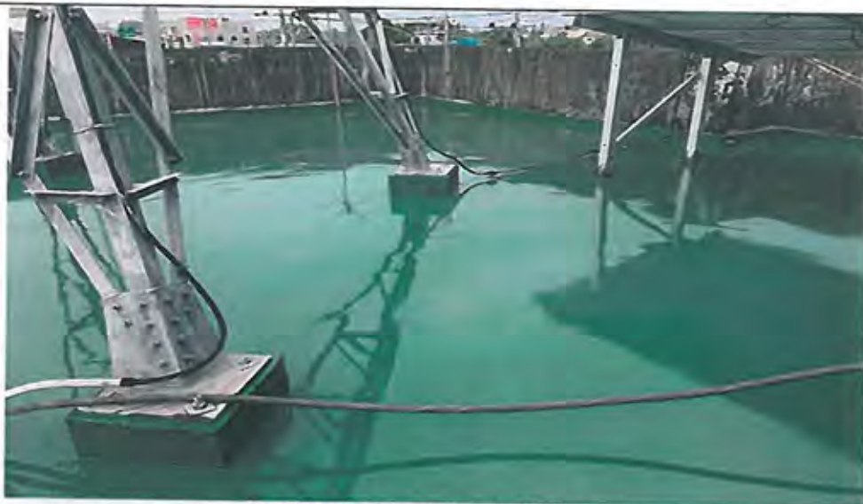
辦公廳舍屋頂防水PU 中材施工
