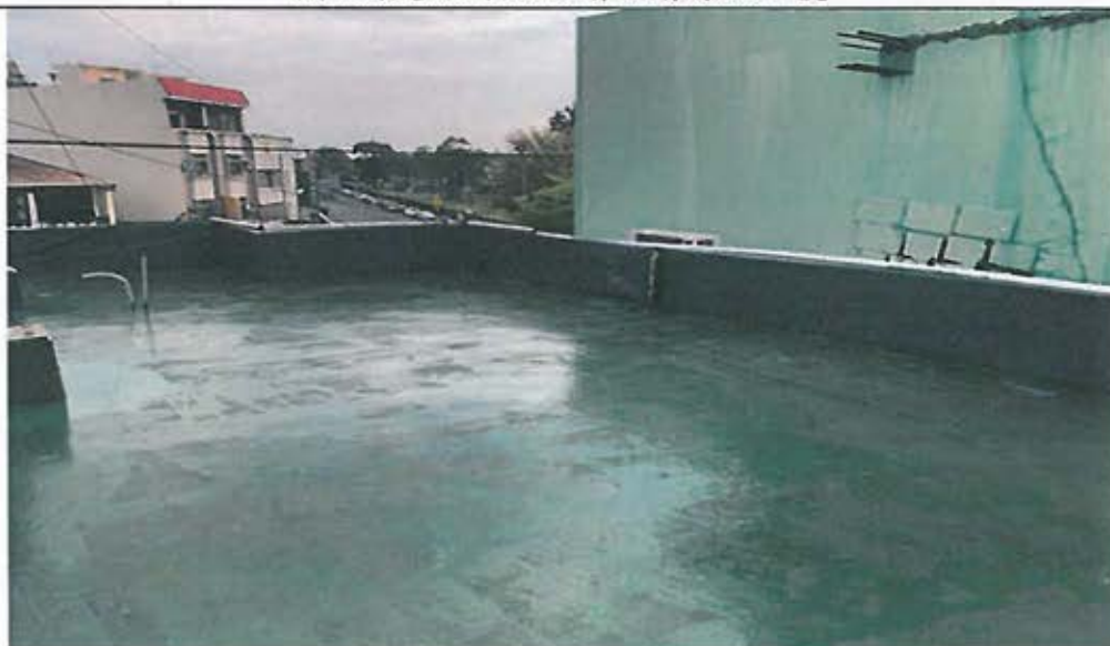
辦公廳舍屋頂防水 PU 底漆施工
