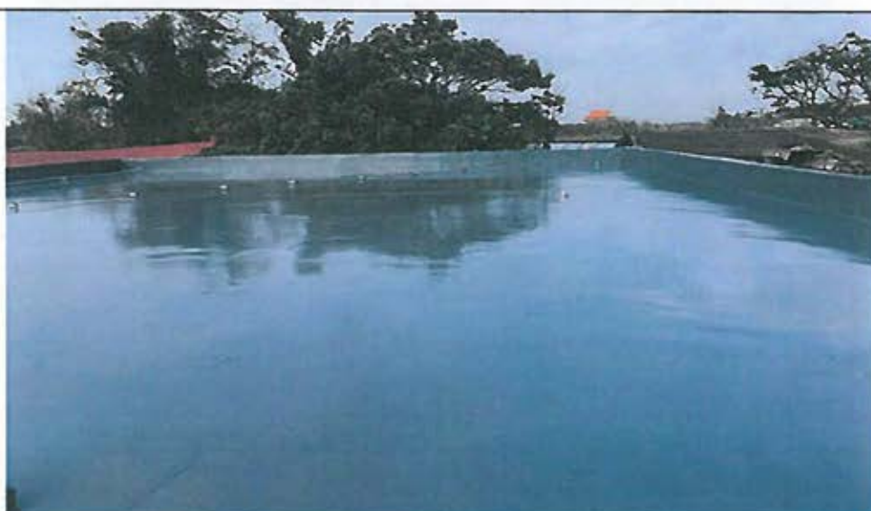
待勤宿舍屋頂地面防水 PU 面漆施工後
