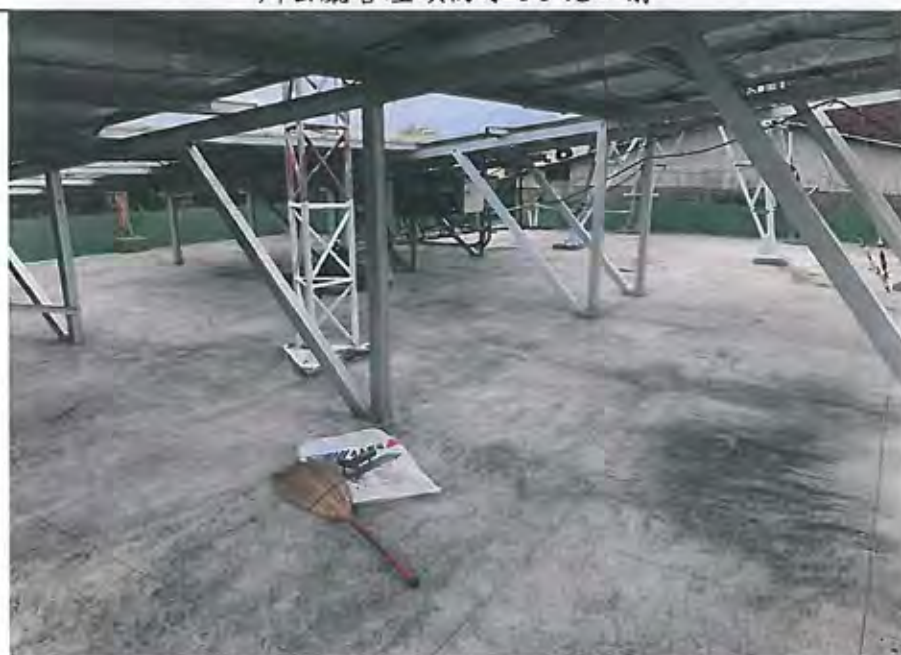
辦公廳舍屋頂地面清潔施工
