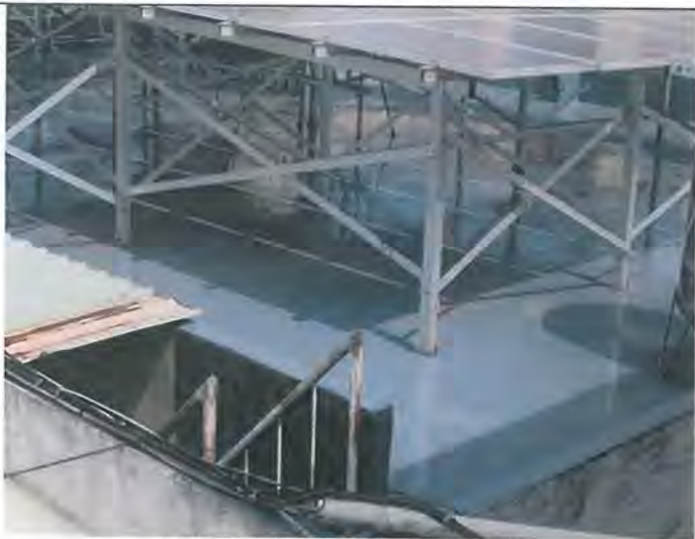
北側辦公廳舍屋頂施作防水 PU 面漆施工
