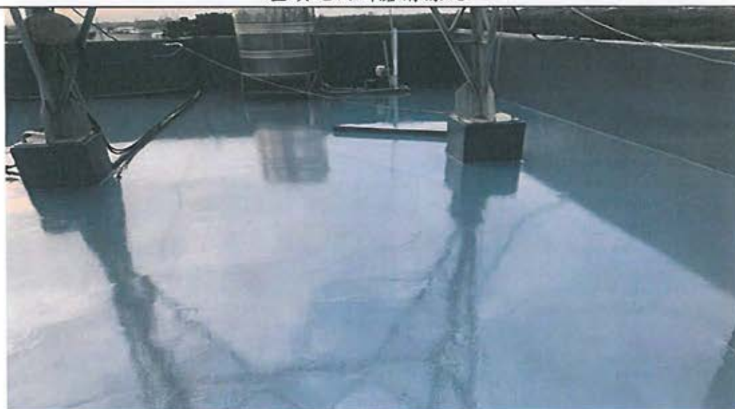
屋頂地面施作防水 PU 施工後
