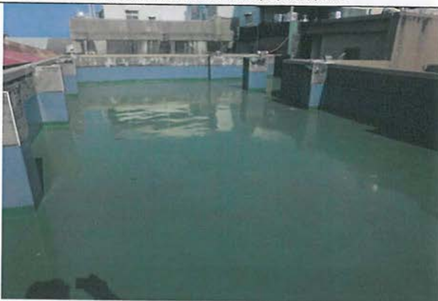
增建辦公廳舍屋頂防水 PU 中材施工
