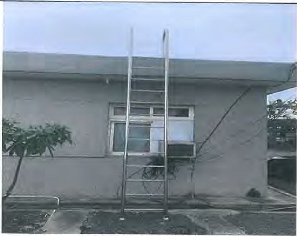
待勤宿舍不銹鋼爬梯施工後
