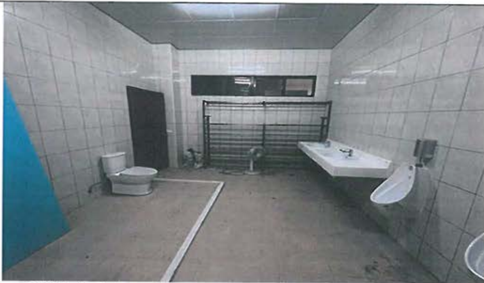
3樓待勤盥洗室牆壁地面鋪貼磁磚及衛浴設備安裝施工
