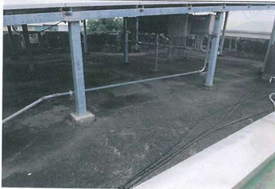
增建辦公廳舍屋頂防水 PU 施工前
