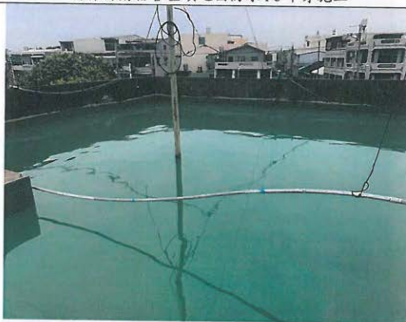
前棟待勤宿舍屋頂地面防水 PU 中才施工
