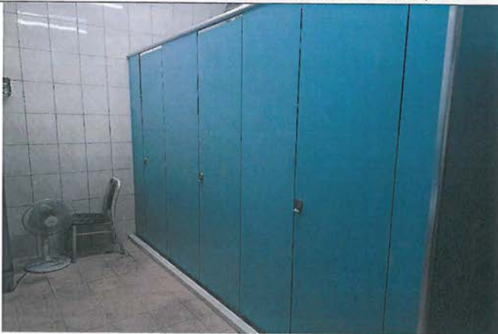
3樓待勤盥洗室浴廁搗擺隔屏施工後
