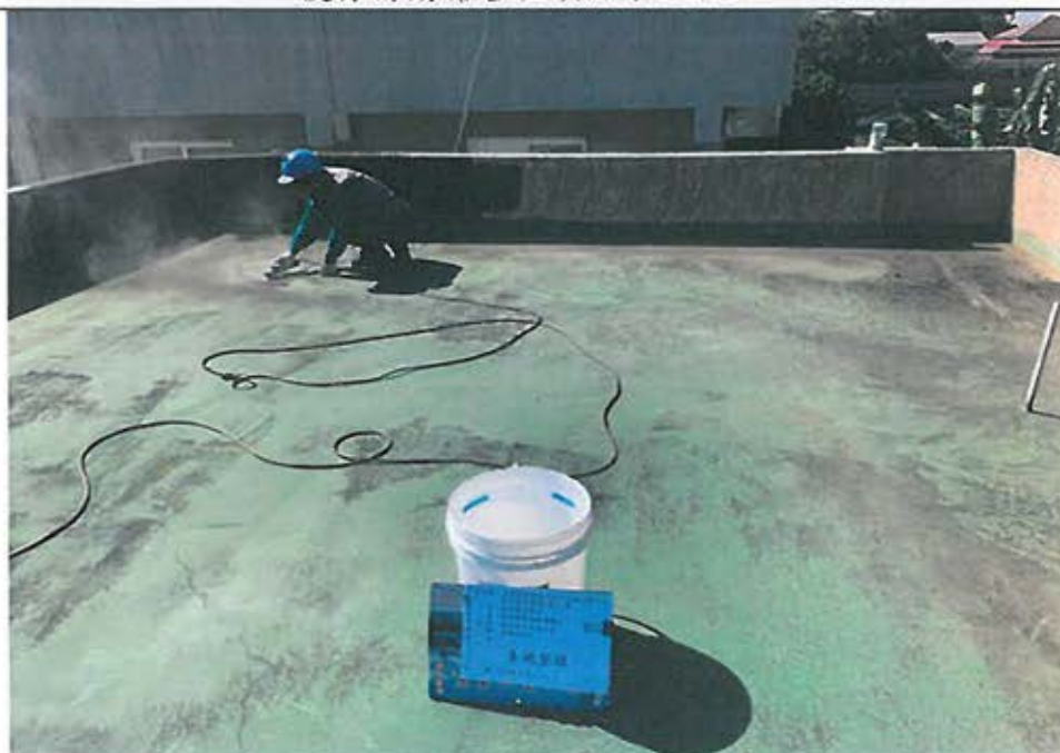
後棟待勤宿舍屋頂地面研磨清潔施工
