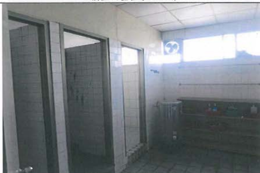
2樓盥洗室整修施工前
