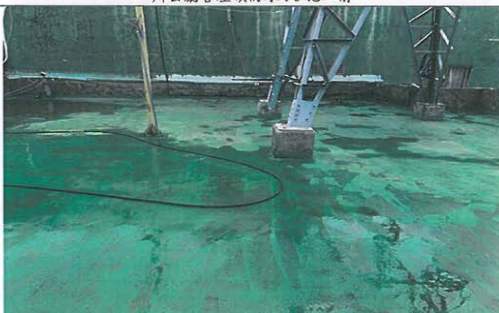
辦公廳舍屋頂地面清洗清潔施工後
