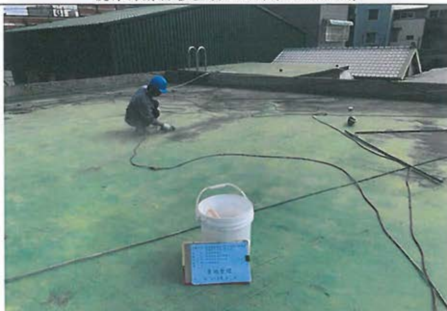
後棟待勤宿舍屋頂地面污穢研磨清潔施工
