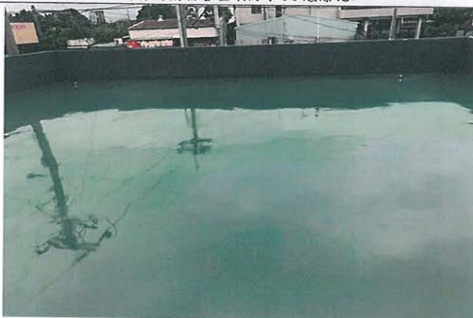
後棟待勤宿舍屋頂防水 PU 中才施工
