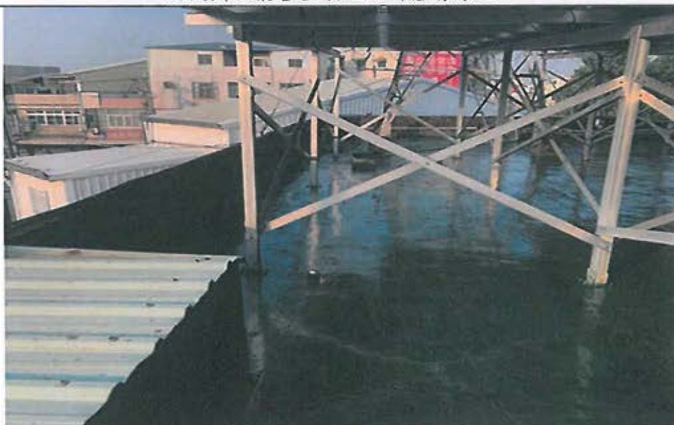
南側辦公廳舍屋頂施作防水 PU 底漆施工
