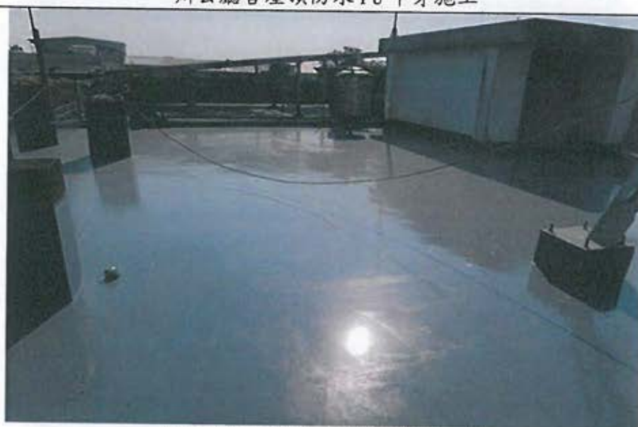
辦公廳舍屋頂防水 PU 面漆施工後
