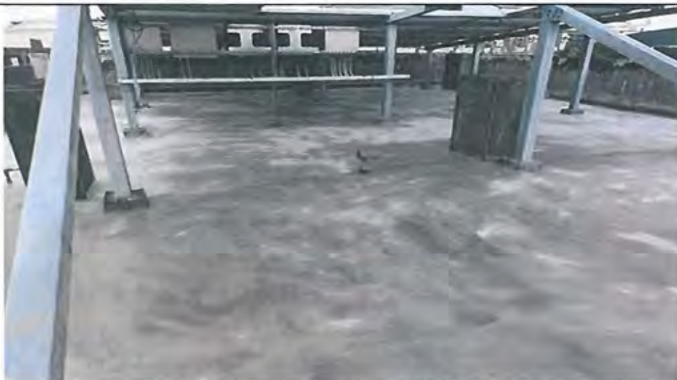
增建辦公廳舍屋頂地面水泥砂漿粉刷施工
