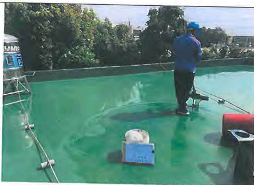
後棟待勤宿舍屋頂地面防水 PU 中才施工
