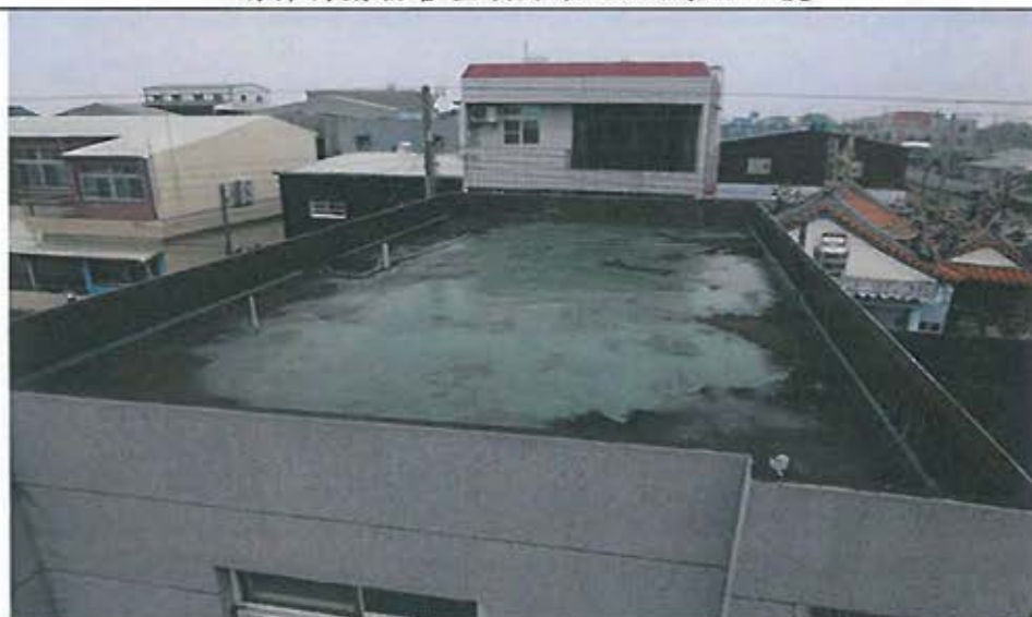
後棟待勤宿舍屋頂防水 PU 施工
