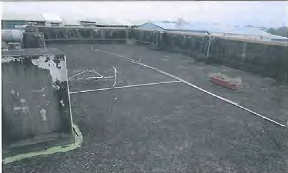
增建辦公廳舍屋頂防水 PU 施工前
