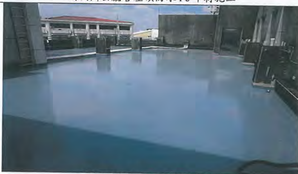
南側辦公廳舍屋頂防水 PU 中材施工
