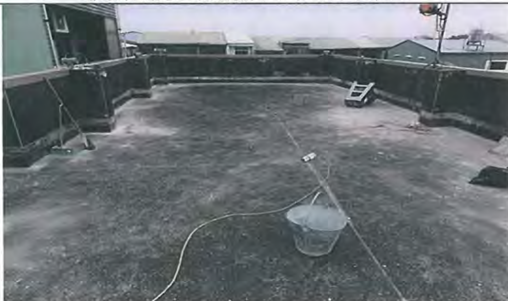
增建辦公廳舍屋頂女兒牆下方磚造檔水墩拆除清除施工
