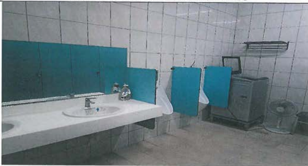
3樓待勤盥洗室洗手台、小便斗等更新施工後
