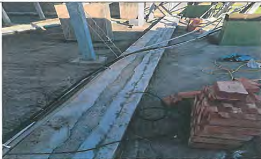
辦公廳舍屋頂伸縮砌磚水泥砂漿粉刷施工
