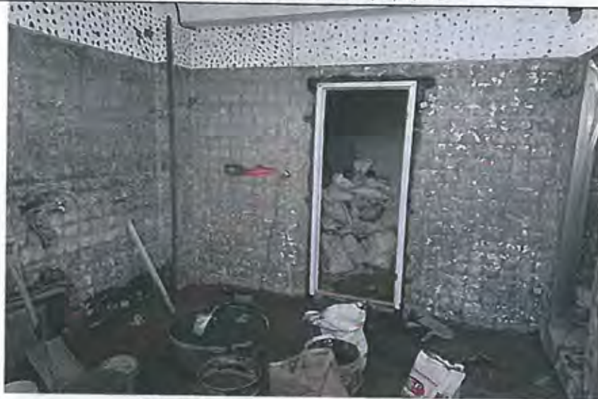
2樓盥洗室牆壁地面磁磚拆除施工
