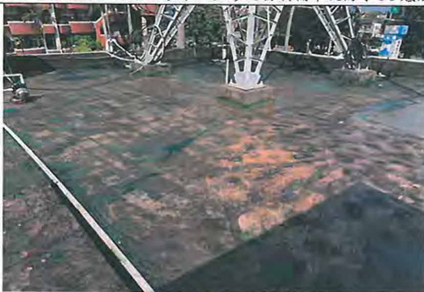
辦公廳舍屋頂防水PU底漆施工
