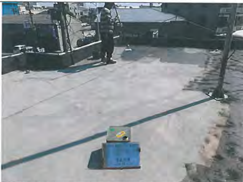
辦公廳舍屋頂地面1：3水泥砂漿＋益膠泥粉刷補平及防水PU底漆施工
