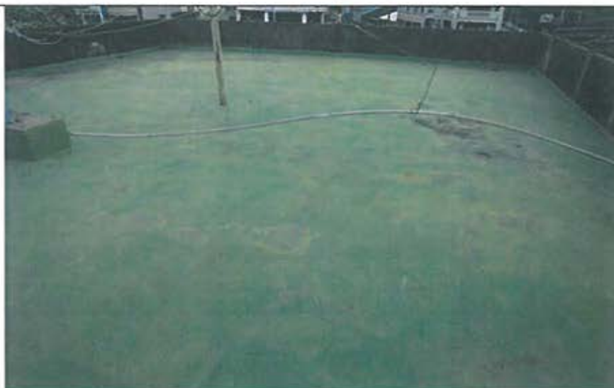
前棟待勤宿舍屋頂防水 PU 施工前
