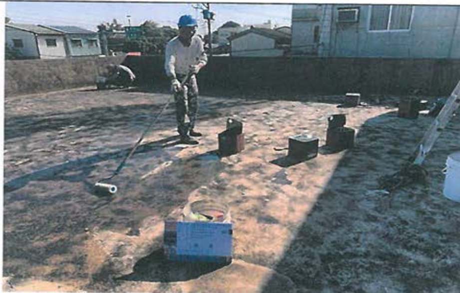
後棟待勤宿舍屋頂防水 PU 底漆施工
