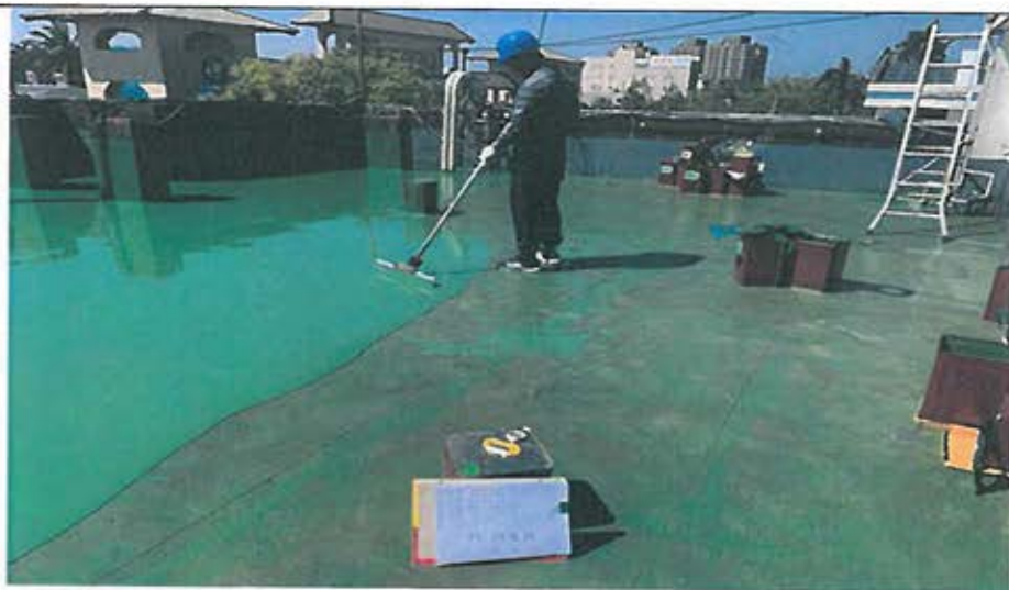
辦公廳舍屋頂地面防水 PU 中才施工
