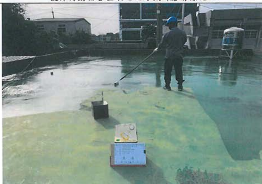
後棟待勤宿舍屋頂地面防水 PU 底漆施工
