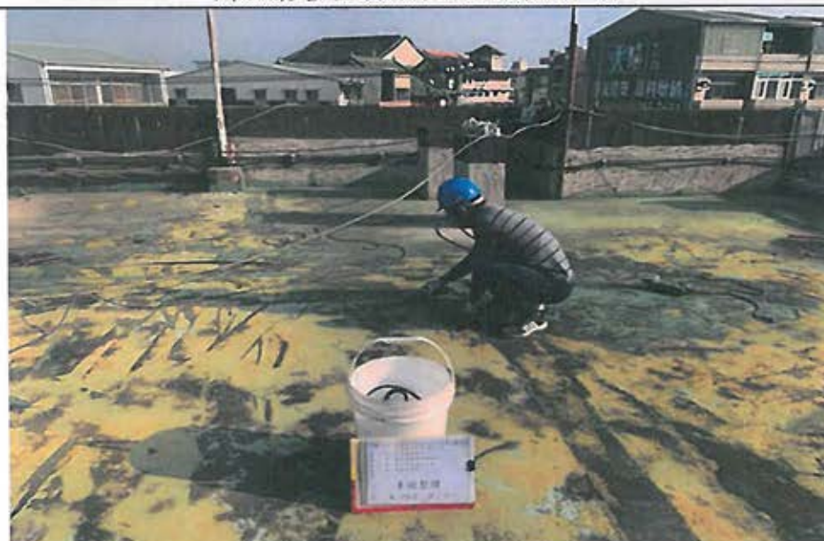
辦公廳舍屋頂地面研磨清潔施工
