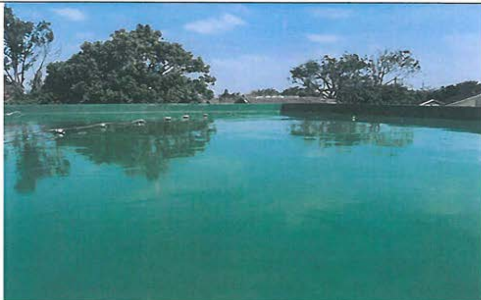
待勤宿舍屋頂地面防水 PU 中才施工
