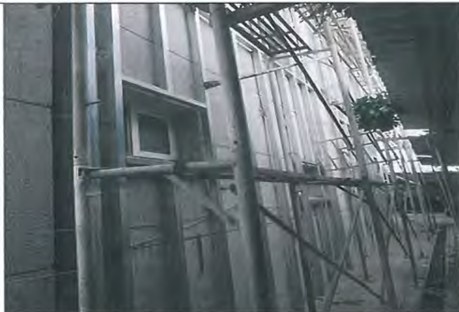
辦公廳舍南側牆壁施工架及 C 型鋼材固定施工
