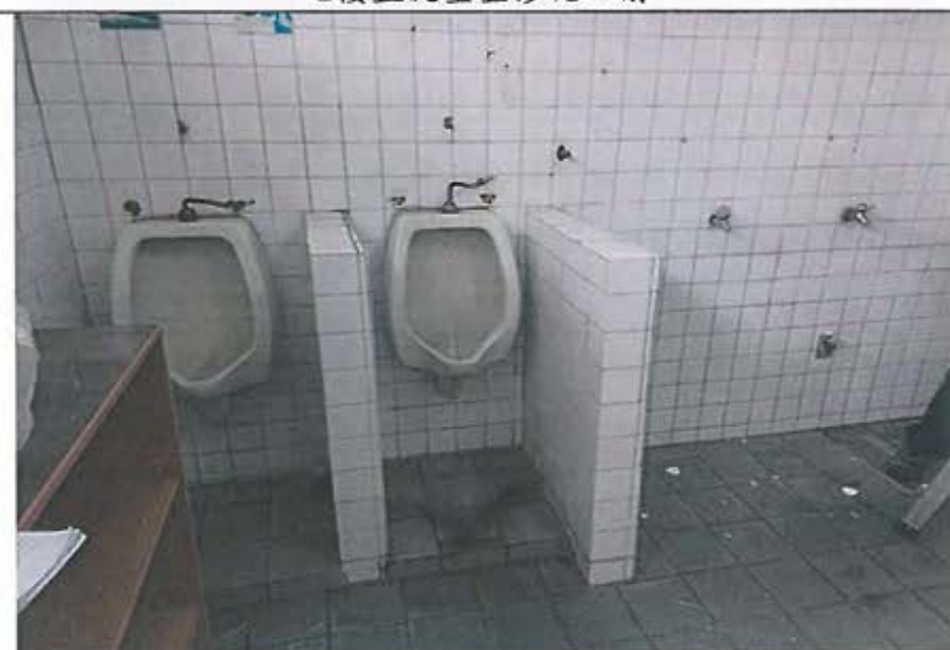
2樓盥洗室整修施工前
