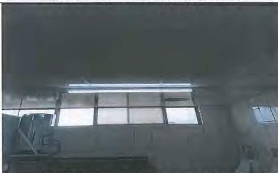
2樓盥洗室輕鋼架天花板及照明燈具更新施工後
