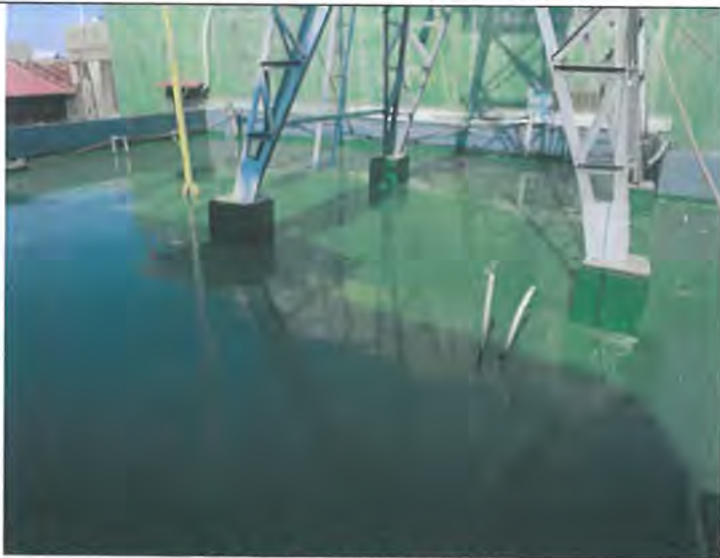
辦公廳舍屋頂防水 PU 中材底漆施工
