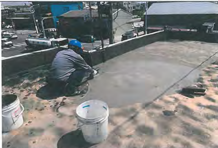
辦公廳舍屋頂地面破損1：3水泥砂漿+益膠泥粉刷補平施工
