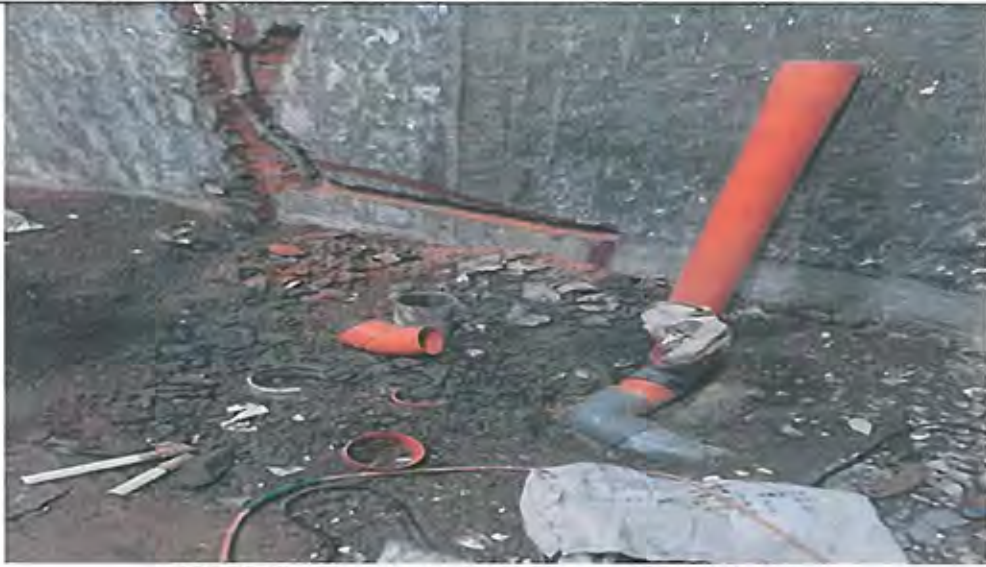
3樓待勤鹽洗室冷熱水管路打鑿配管施工
