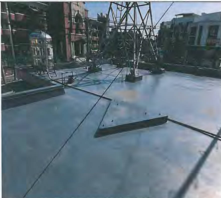
辦公廳舍屋頂防水 PU 面漆施工
