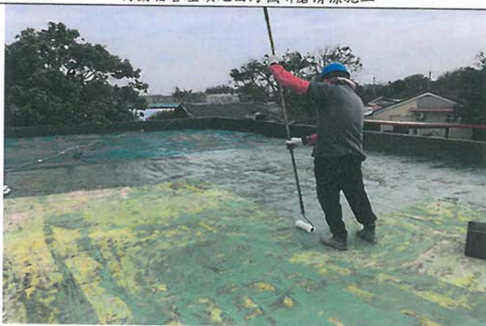
待勤宿舍屋頂地面防水 PU 底漆施工
