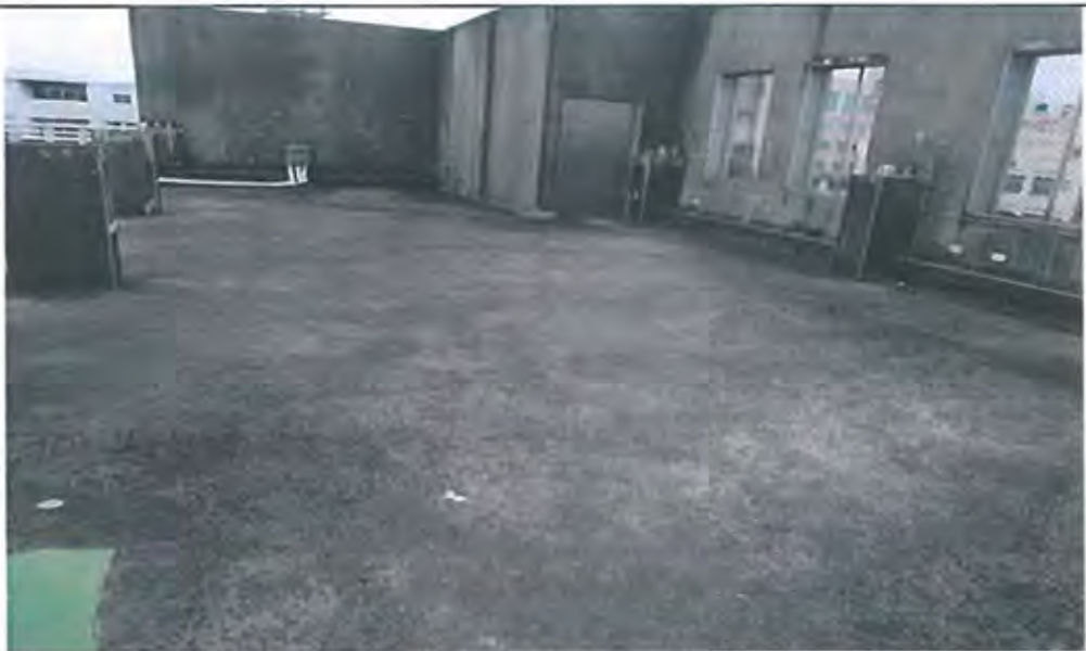
南側辦公廳舍屋頂施作防水 PU 施工前
