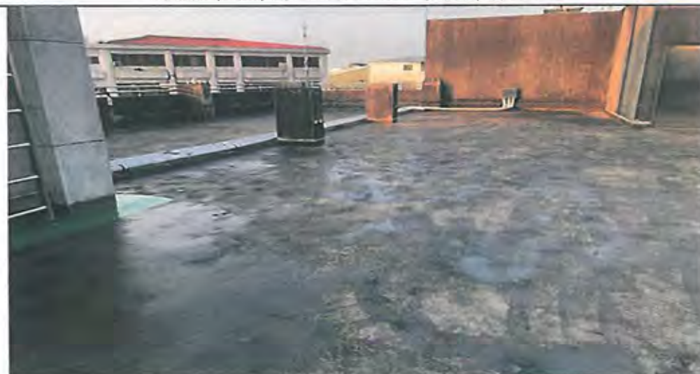
南側辦公廳舍屋頂施作防水 PU 底漆施工
