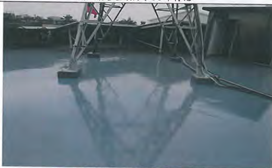
辦公廳舍屋頂防水PU 面漆施工後
