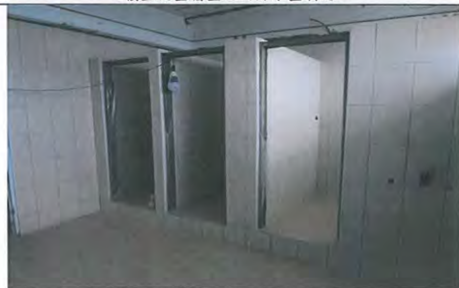
2樓盥洗室牆壁地面鋪貼磁磚施工
