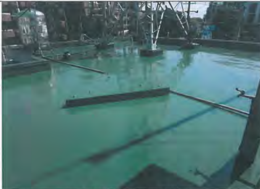
辦公廳舍屋頂防水 PU 中才施工
