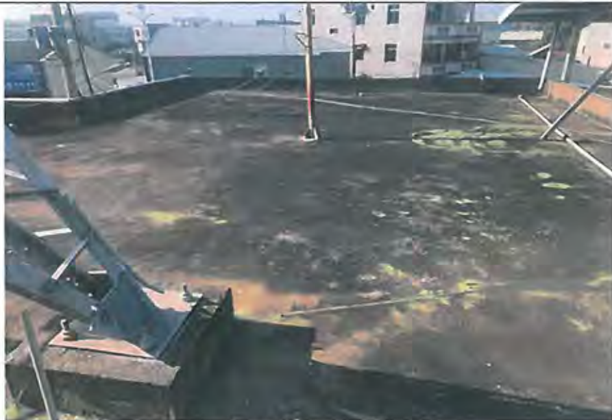
辦公廳舍屋頂防水 PU 施工前
