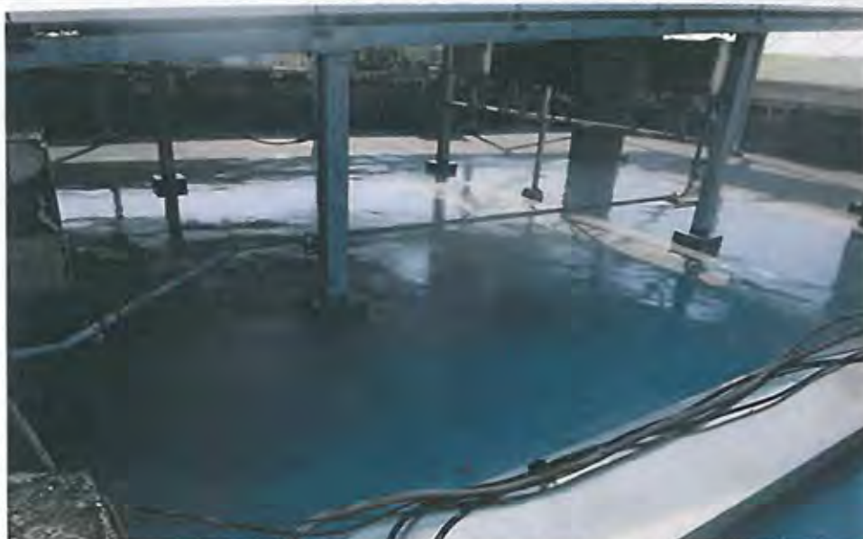
增建辦公廳舍屋頂防水 PU 面漆施工後
