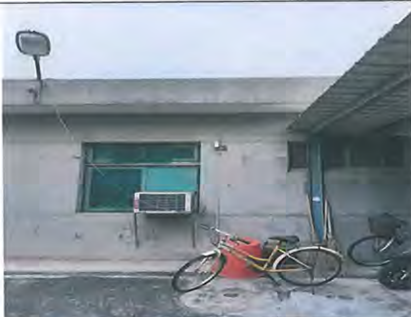
後棟待勤宿舍不銹鋼爬梯施工前
