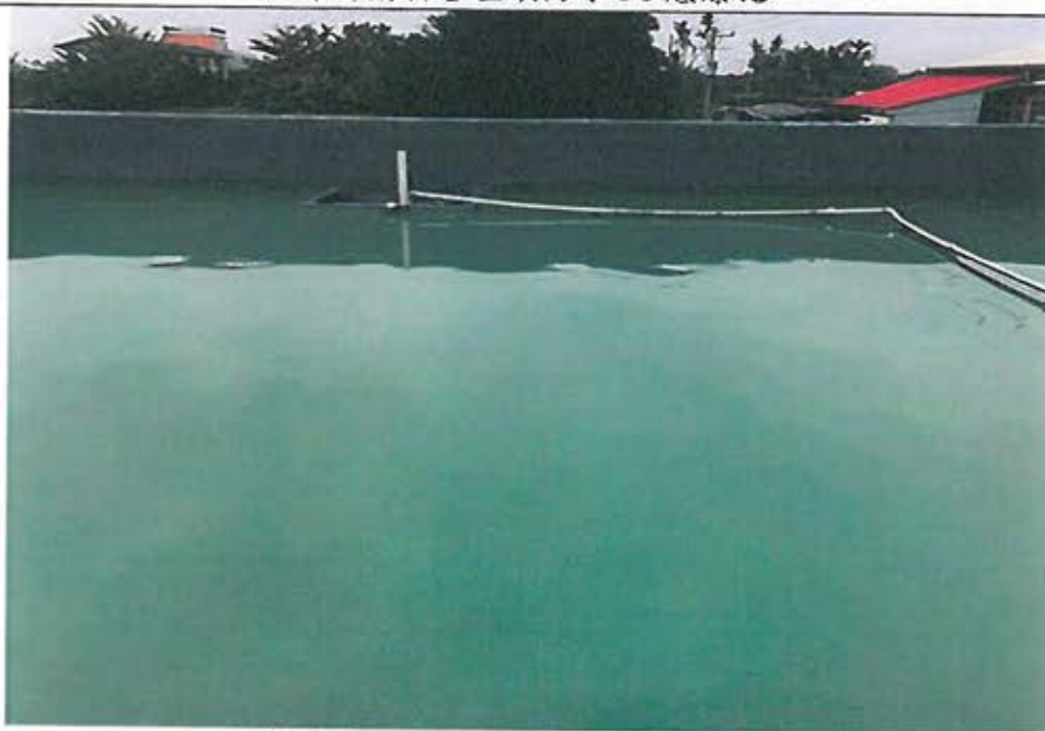
後棟待勤宿舍屋頂防水 PU 中才施工
