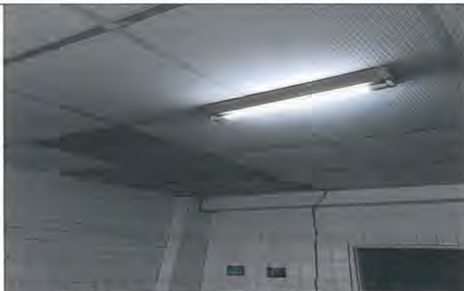
2樓盥洗室輕鋼架天花板及照明燈具更新施工前
