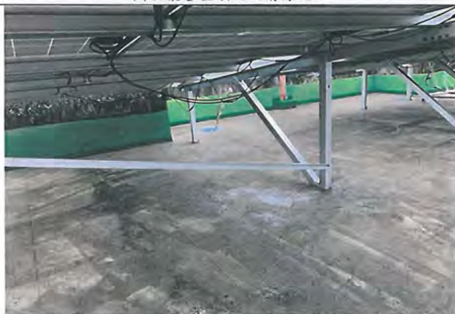
辦公廳舍屋頂防水 PU 面漆施工
