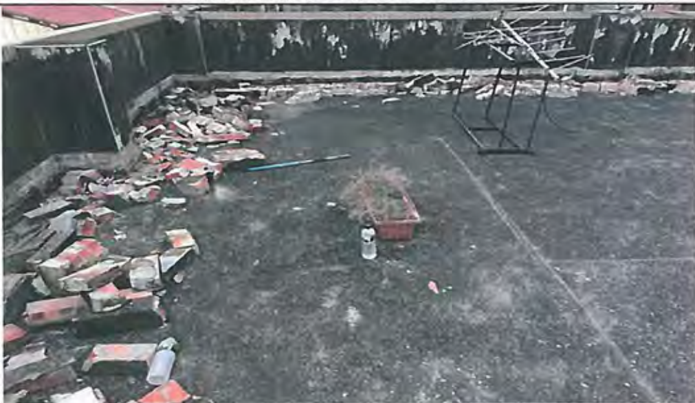
增建辦公廳舍屋頂女兒牆下方磚造檔水墩拆除施工
