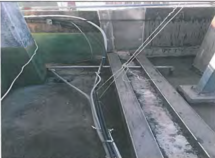
辦公廳舍屋頂伸縮砌磚水泥砂漿粉刷施工
