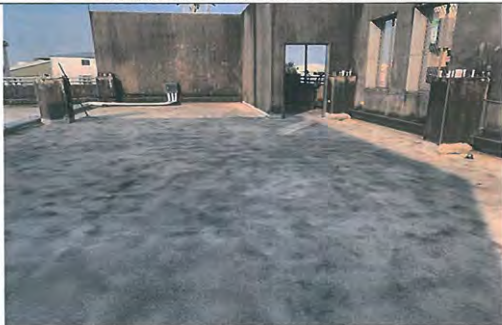
南側辦公廳舍屋頂地面研磨清潔施工
