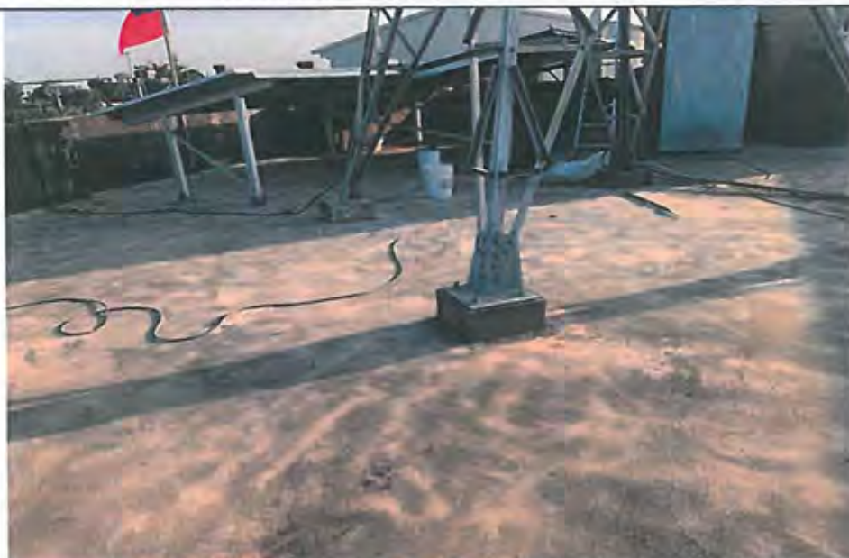
辦公廳舍屋頂水泥地面污穢研磨清潔施工中
