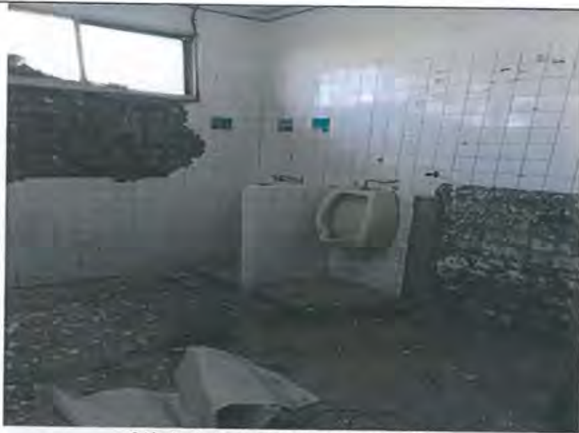
2樓盥洗室牆壁地面磁磚拆除施工
