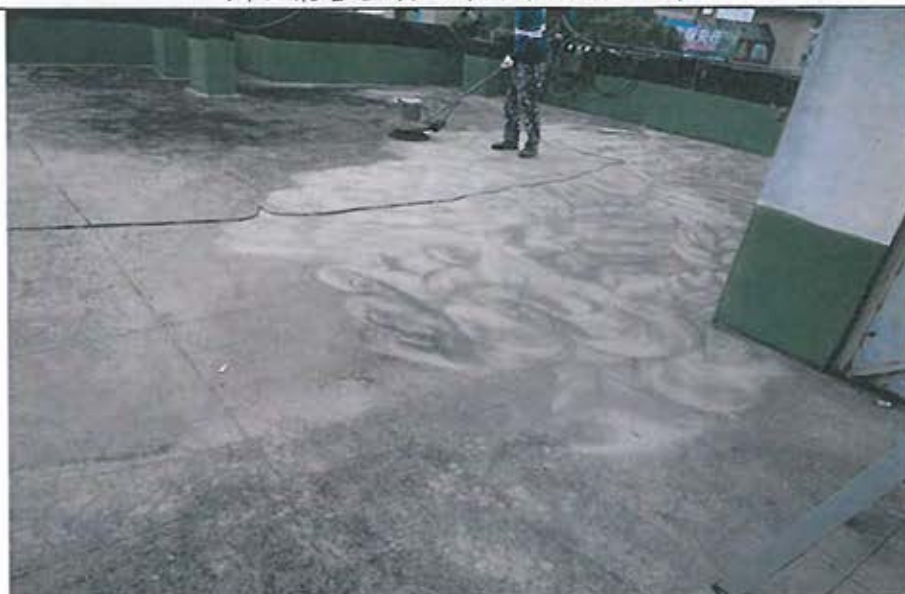
辦公廳舍屋頂地面研磨清潔施工
