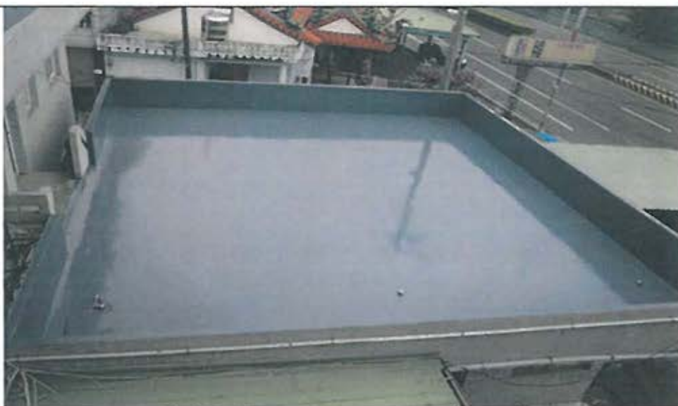
前棟待勤宿舍屋頂防水 PU 面漆施工後
