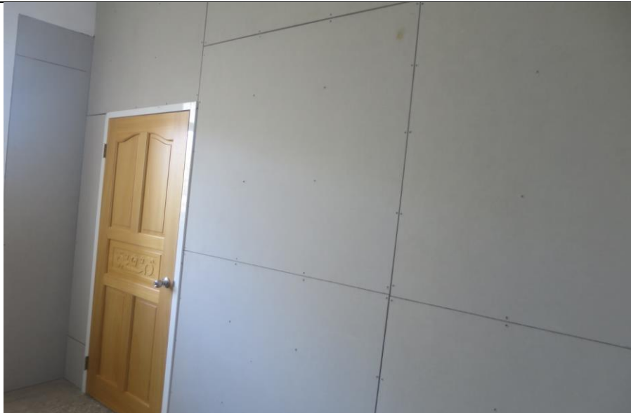
待勤室矽酸鈣板輕隔間施工
