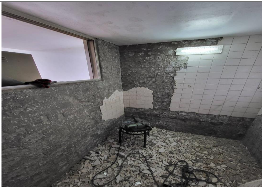
待勤室盥洗室整修磁磚打除施工
