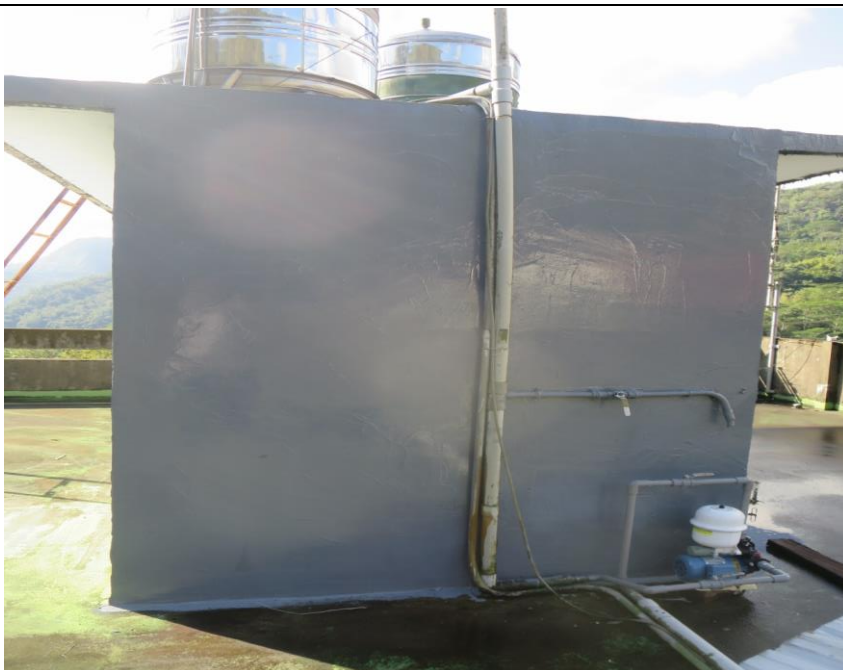
待勤宿舍樓梯間外牆施作不垂流防水 PU 施工後
