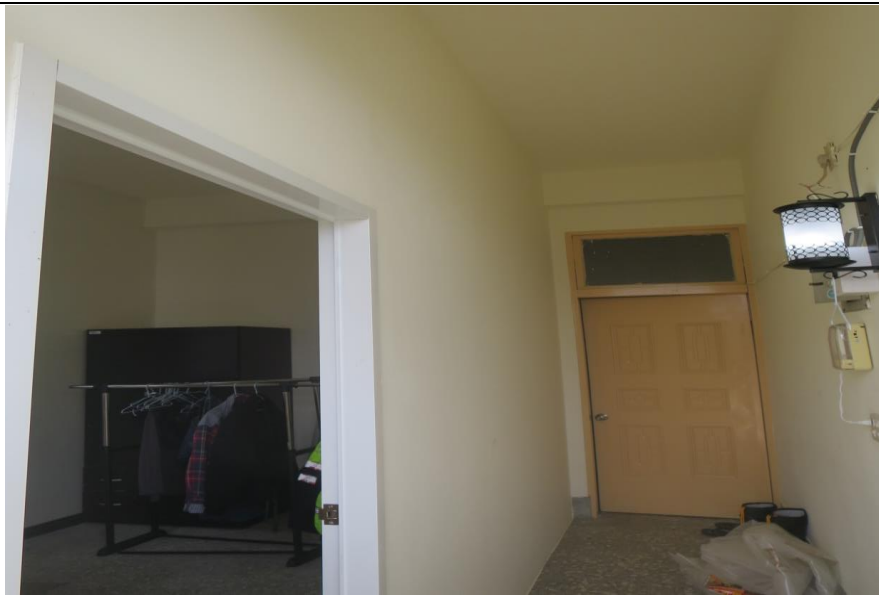
待勤室矽酸鈣板輕隔間油漆粉刷施工後
