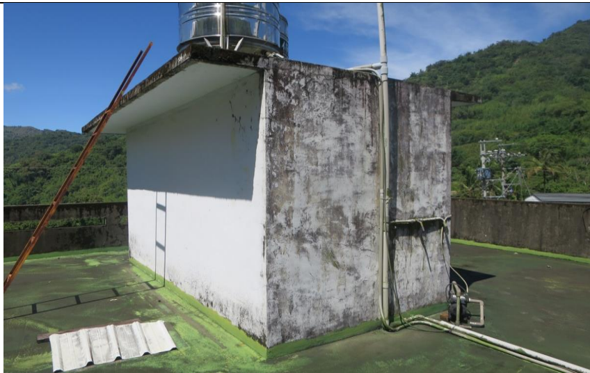
待勤宿舍樓梯間外牆施作不垂流防水 PU 施工前
