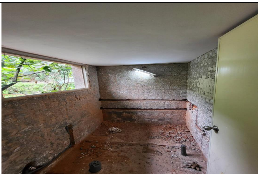
待勤室盥洗室整修磁磚及冷熱水打鑿配管施工
