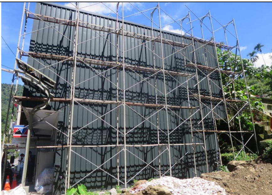
待勤宿舍外牆滲水釘封烤漆板施工鷹架施工
