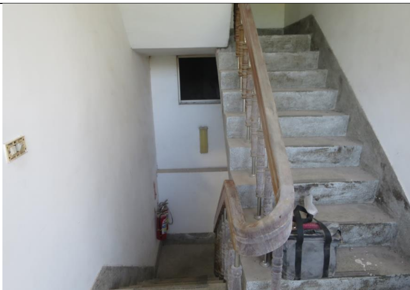
待勤宿舍樓梯牆壁及扶手油漆粉刷施工前
