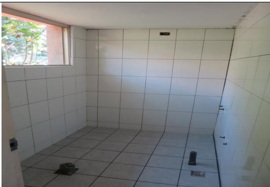
待勤室盥洗室牆壁鋪貼磁磚施工
