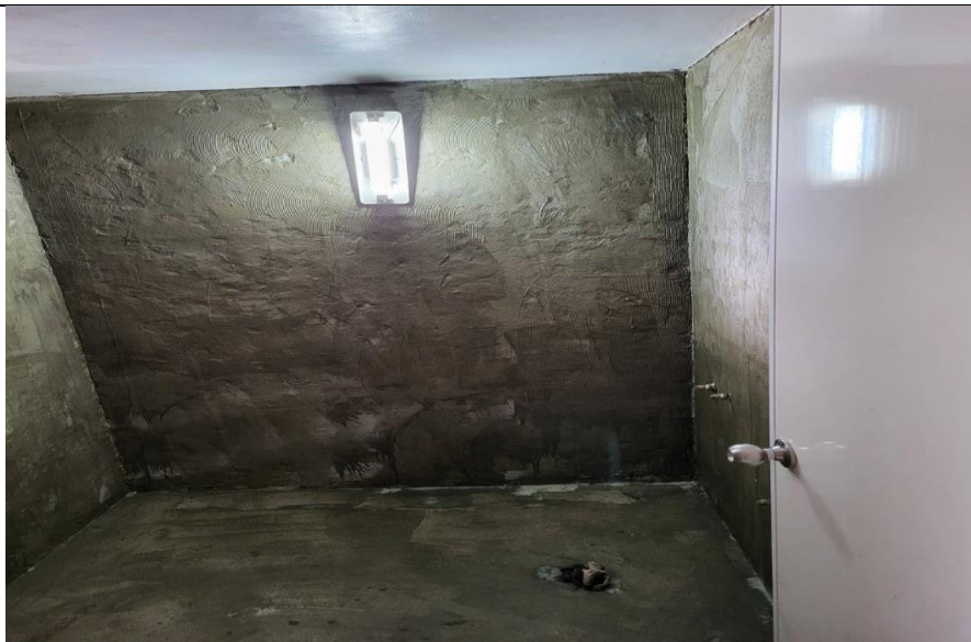
待勤室盥洗室牆壁防水施工
