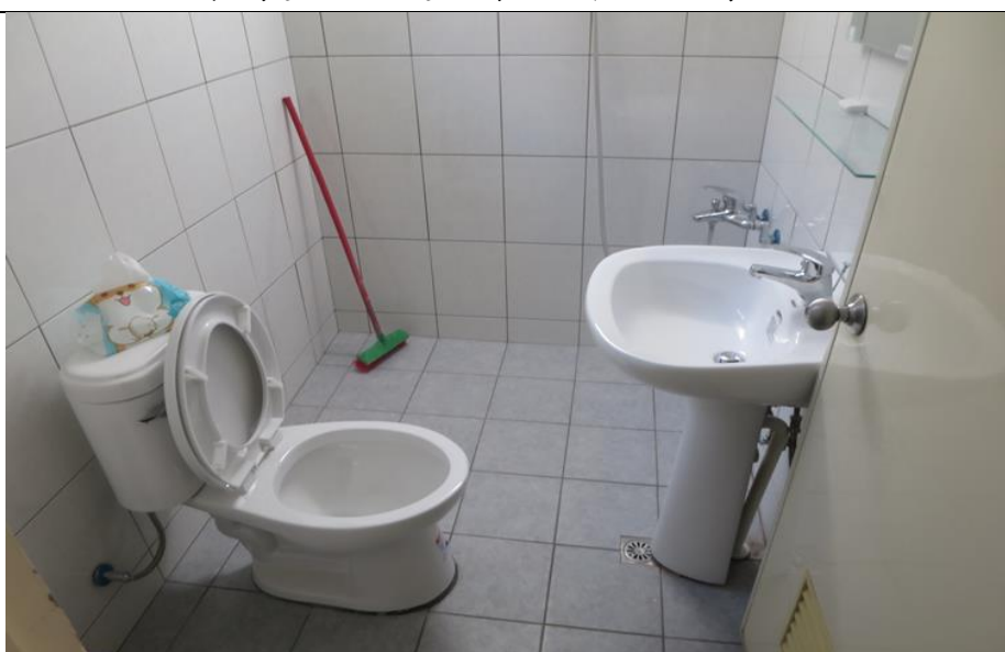
待勤室盥洗室牆壁、地面鋪貼及盥洗設備安裝施工後
