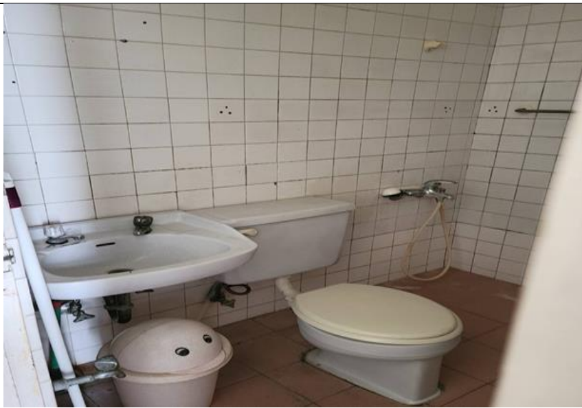
待勤室盥洗室整修施工前
