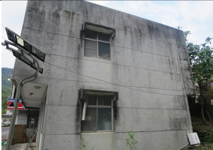
待勤宿舍外牆滲水釘封烤漆板施工前
