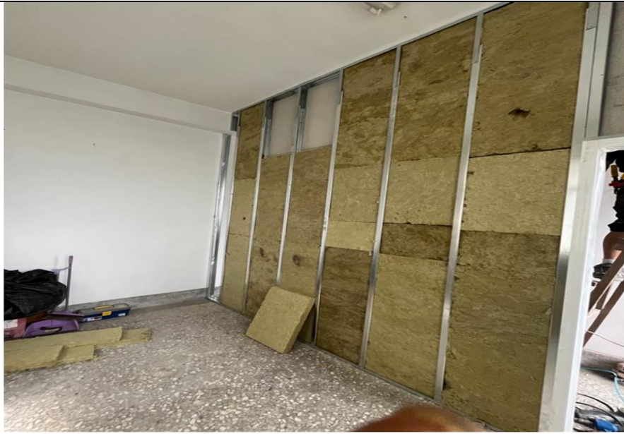
待勤宿舍輕隔間施工
