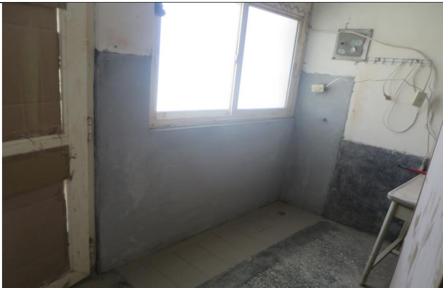
待勤室外間泥做料理台打除水泥砂漿粉刷施工
