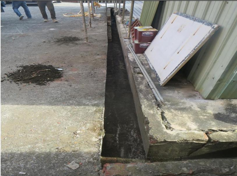
待勤宿舍排水溝破損整修施工
