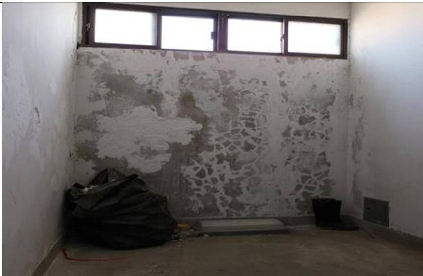
待勤宿舍樓梯牆壁壁癌油漆脫落修繕施工前
