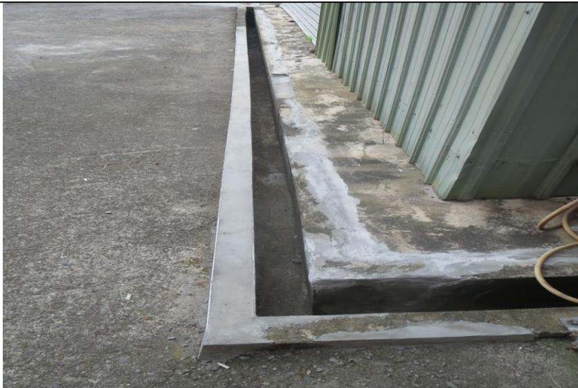
待勤宿舍排水溝破損整修施工後
