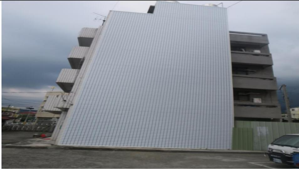
待勤宿舍外牆滲水釘封複合金屬壁板施工後
