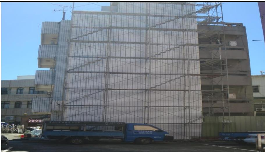
待勤宿舍外牆滲水釘封複合金屬壁板及施工架施工
