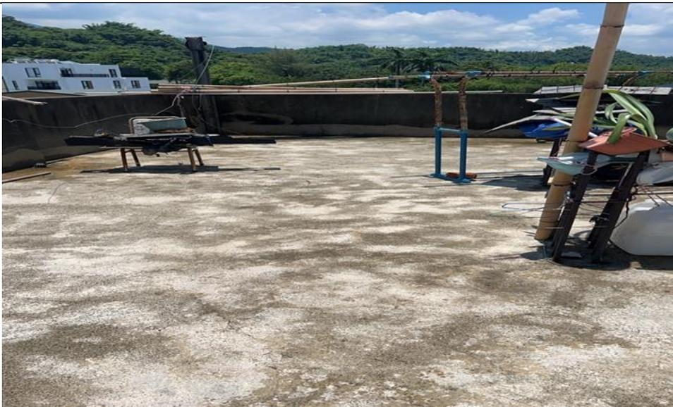
待勤宿舍屋頂施作防水 PU 地面研磨清潔施工前
