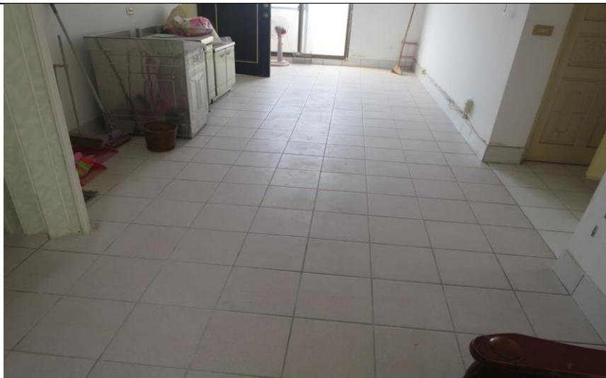
勤宿舍待勤宿舍地磚破損修繕施工後
