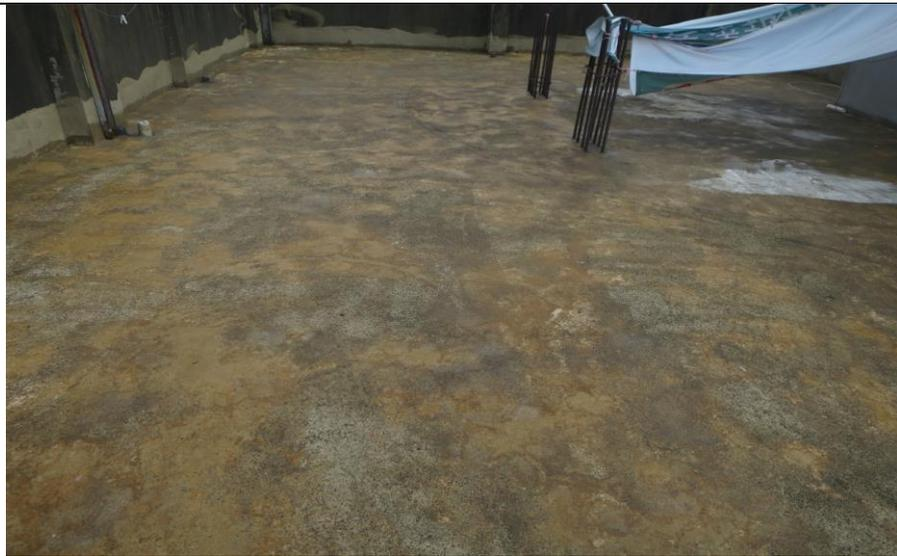
待勤宿舍屋頂施作防水 PU 底材施工中
