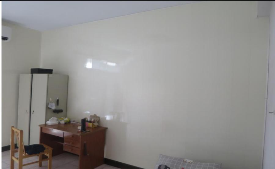
2樓女警待勤室外間牆壁釘封塑膠板+防潮布施工後
