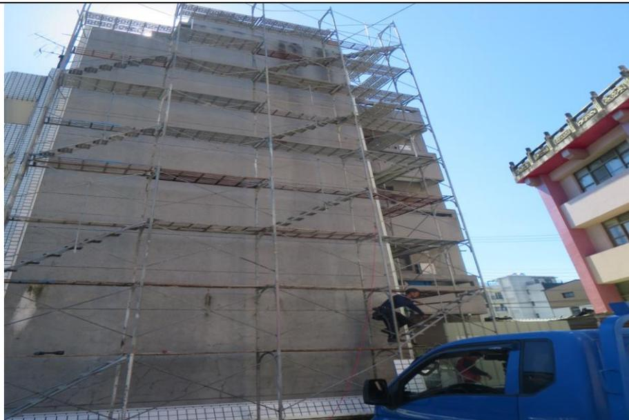
待勤宿舍外牆滲水釘封複合金屬壁板施工架搭設施工
