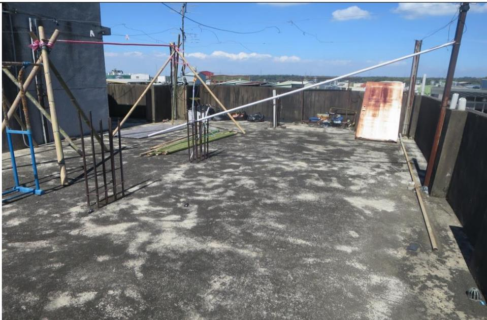
待勤宿舍屋頂漏水施作防水 PU 施工前
