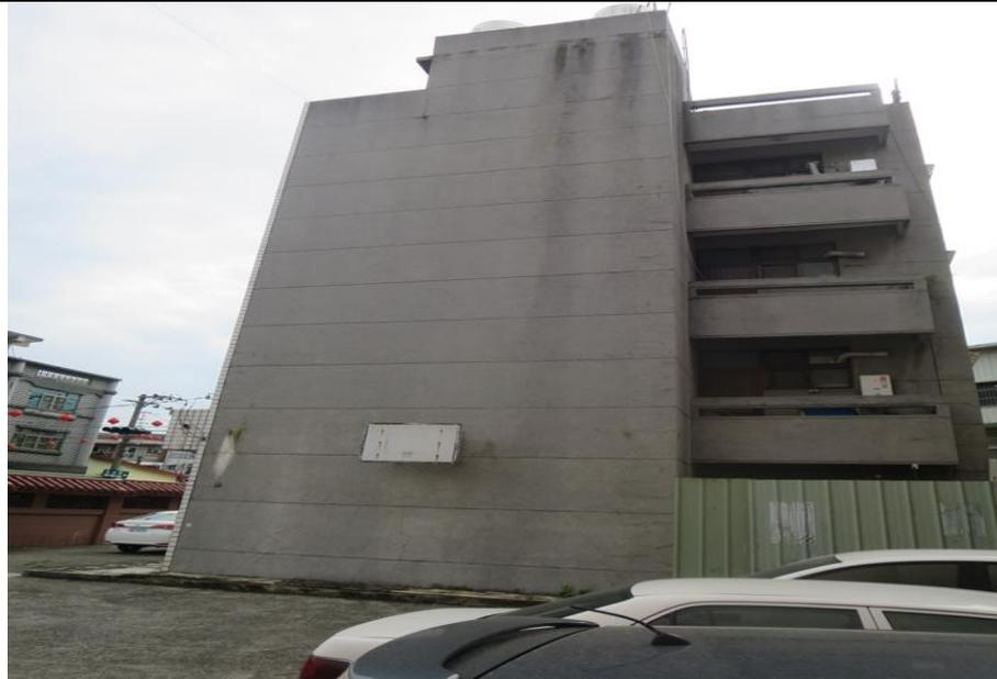
待勤宿舍外牆滲水釘封複合金屬壁板(施工前)1
