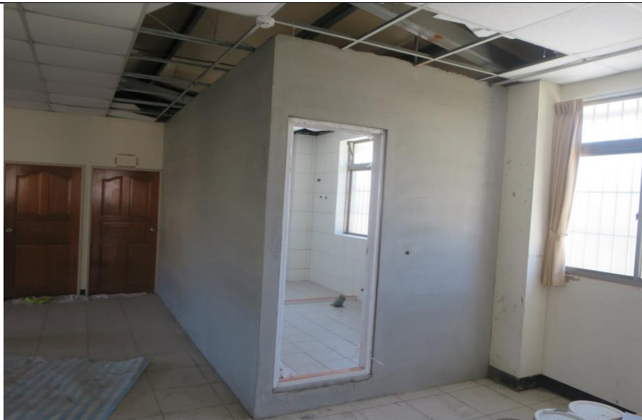
盥洗室外牆1：3水泥砂漿粉光施工
