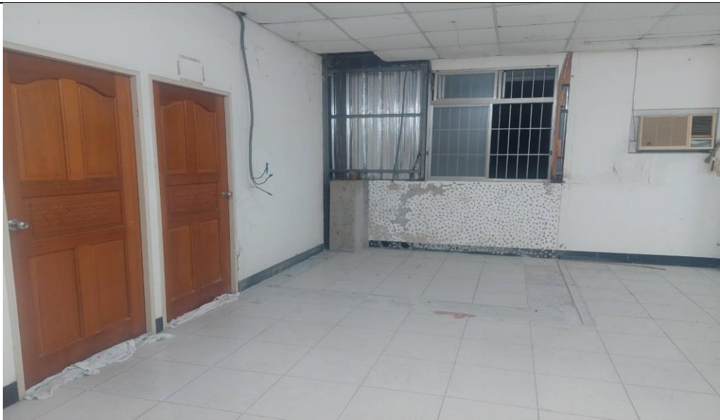
既有花格鋁隔間拆除施工
