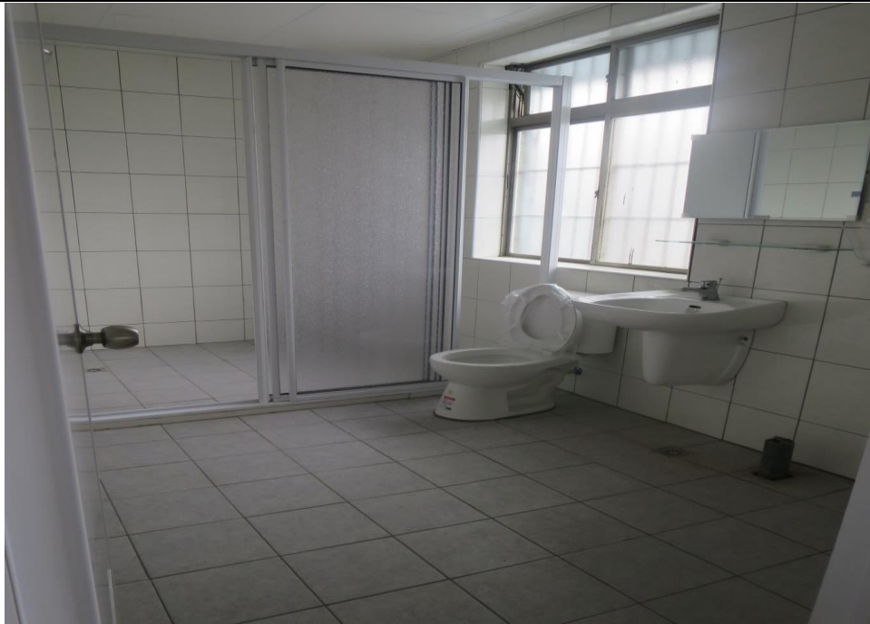
盥洗室乾濕分離鋁拉門及盥洗設備安裝施工後
