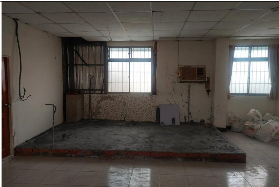
新建盥洗室地面水泥澆灌增高施工
