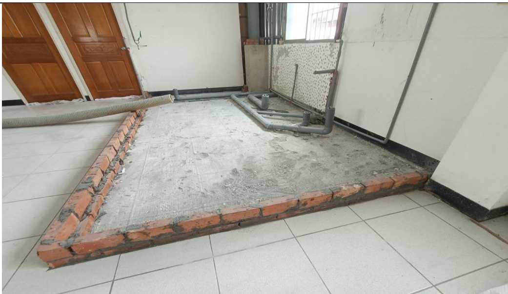
新建盥洗室給排水配管及地面磁磚打除
