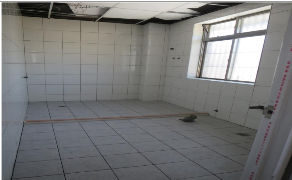
盥洗室牆壁地面貼磚施工
