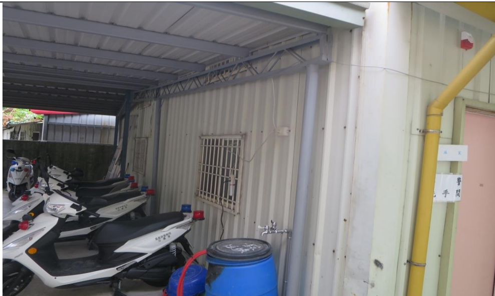
室外廁所屋頂烤漆鋼板銹蝕拆除施工前
