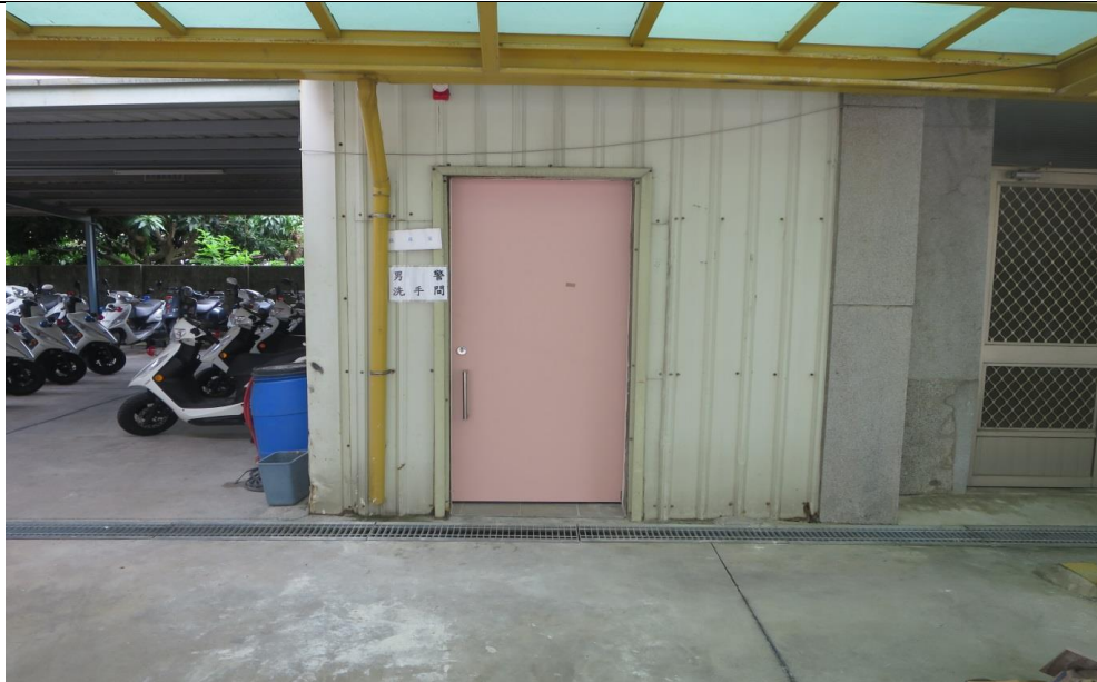
室外廁所正面牆壁烤漆鋼板銹蝕拆除施工前
