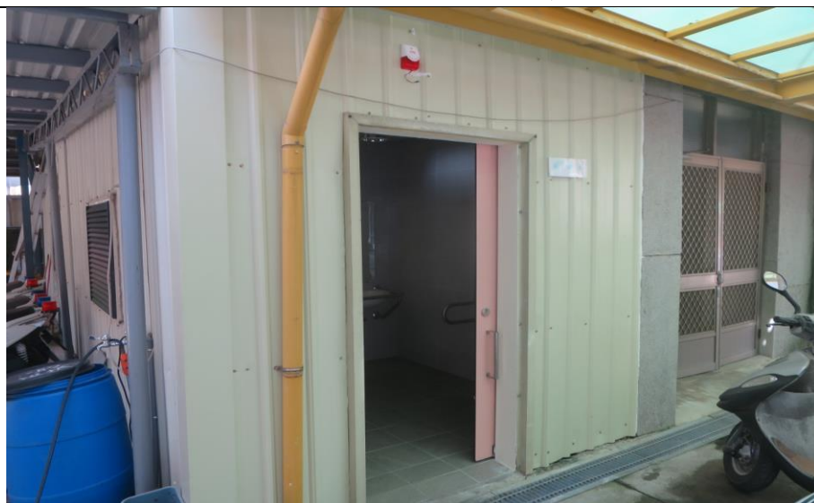
室外廁所正面牆壁烤漆鋼板銹蝕拆除更新施工後
