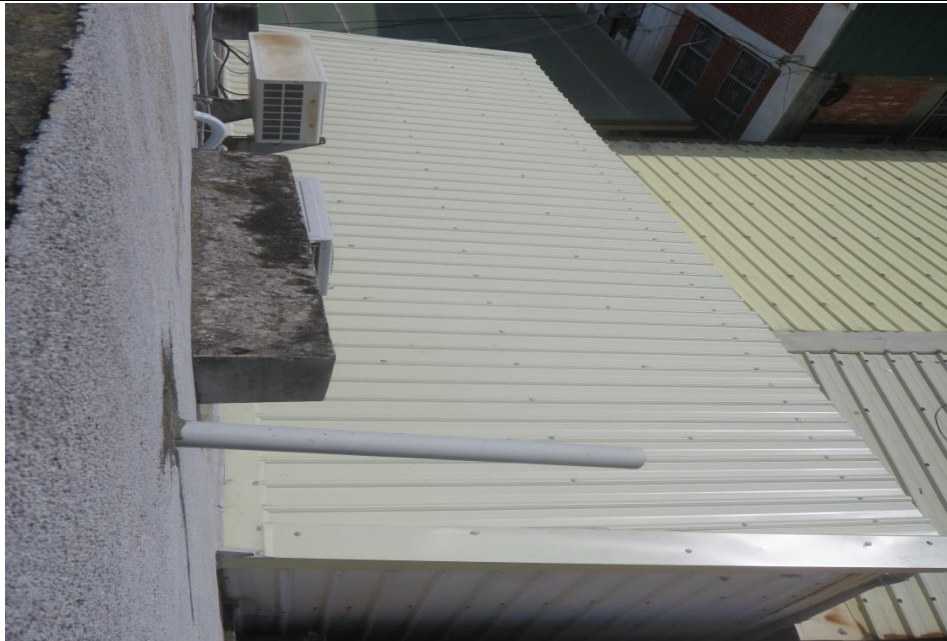
室外廁所屋頂烤漆鋼板銹蝕拆除更新施工後
