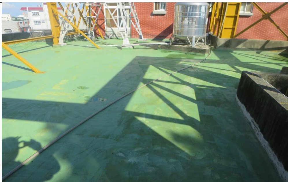
屋頂地面研磨清潔施工
