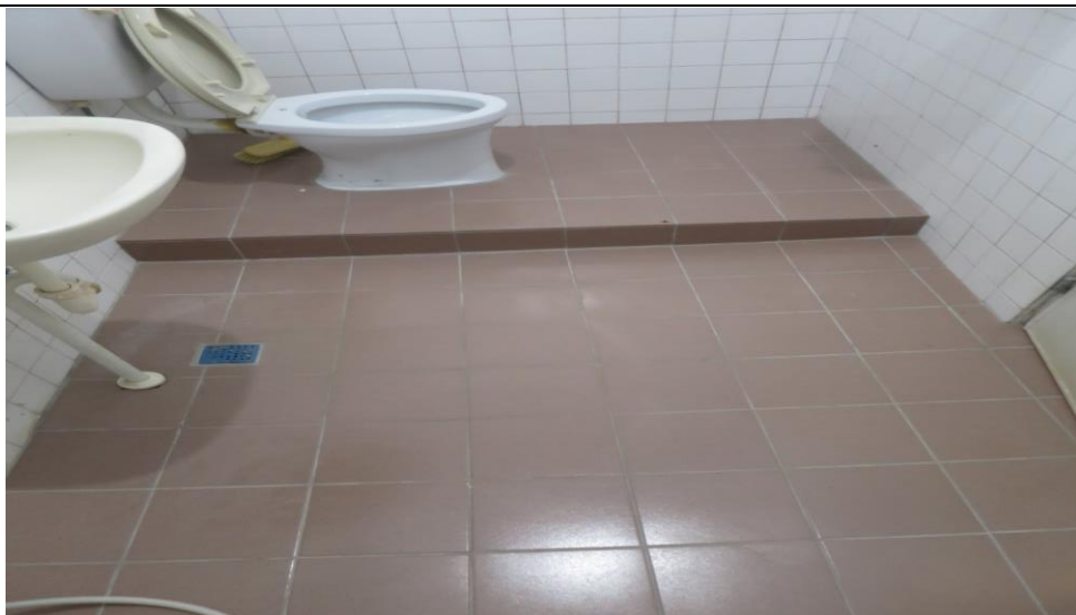
所長待勤室盥洗室地面鋪貼20×20cm磁磚施工後
