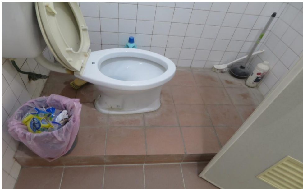
所長待勤室盥洗室地面鋪貼20×20cm磁磚施工前
