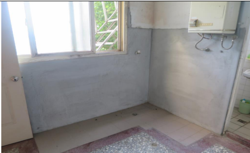
副所長待勤室泥做料理台拆除牆壁水泥砂漿粉光及地面貼磚施工
