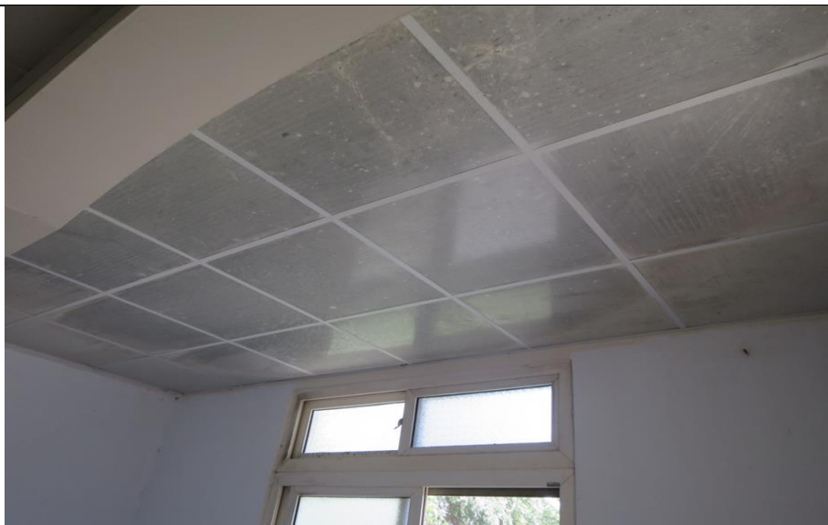
樓梯通道輕鋼架天花板污穢更新施工前
