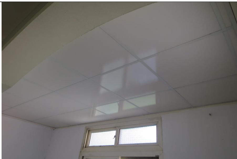
樓梯通道輕鋼架天花板污穢更新施工後
