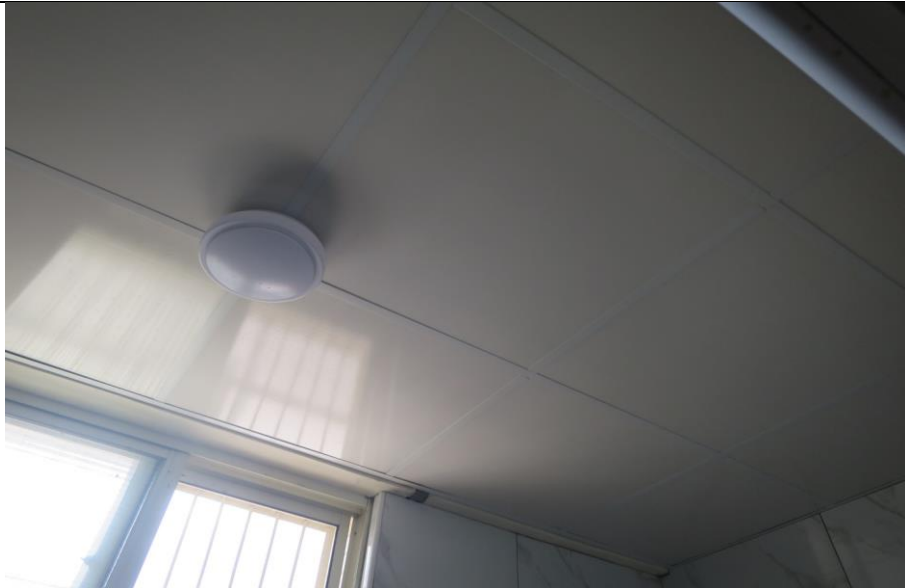
待勤室盥洗室輕鋼架天花板及照明燈具更新施工後
