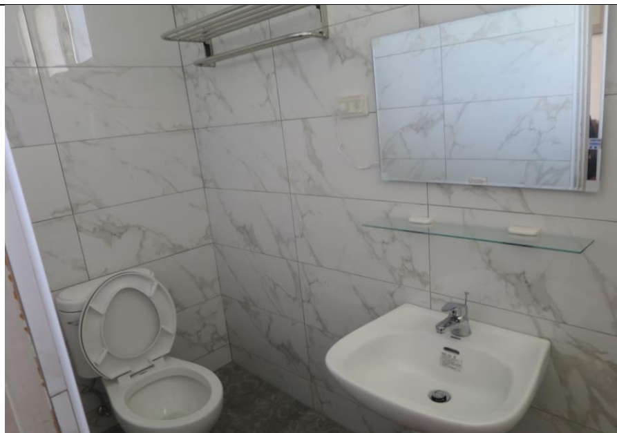
待勤室盥洗室冠矽設備安裝施工
