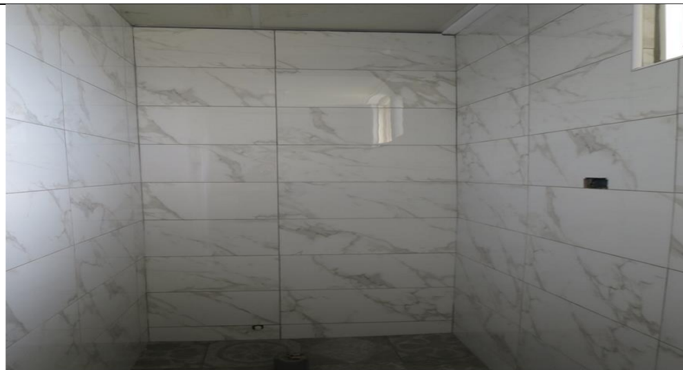
待勤室盥洗室牆壁磁磚鋪貼施工
