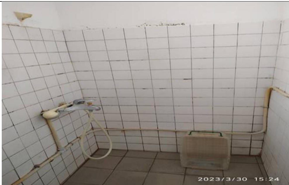
待勤室盥洗室整修施工前
