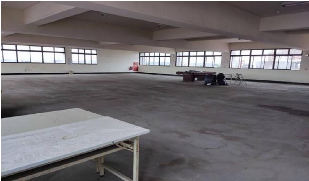
4樓增設待勤室輕隔間施工前
