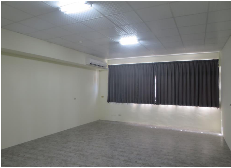
待勤室窗簾布及油漆粉刷施工後
