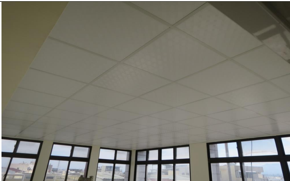
待勤室輕鋼架天花板(石膏板+塑膠面)施工
