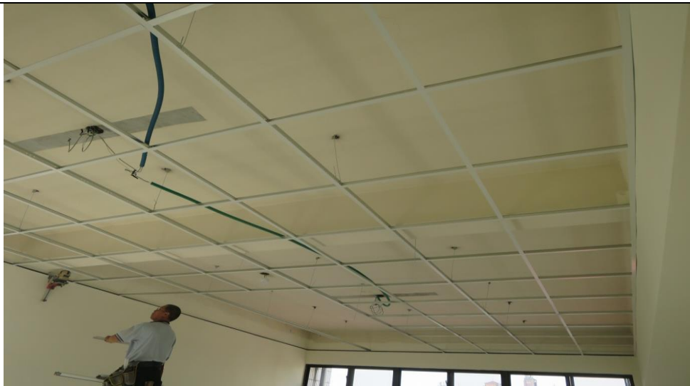
待勤室輕鋼架天花板骨材施工
