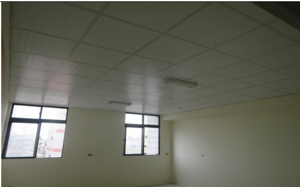
待勤室輕鋼架天花板(石膏板+塑膠面)及照明燈具及油漆粉刷施工後
