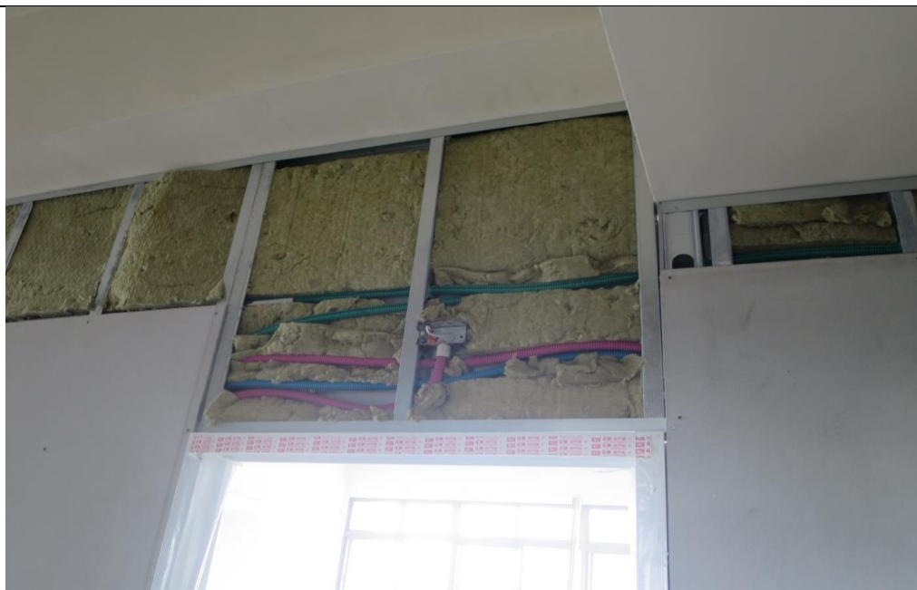
待勤室9mm矽酸鈣板輕隔間填充隔音及電源配線施工
