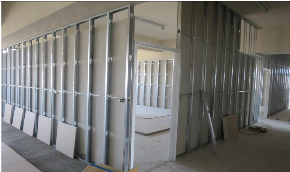
待勤室9mm矽酸鈣板輕隔間+填充隔音岩棉施工
