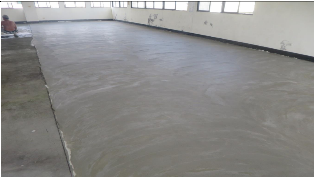
地面益膠泥及水泥砂漿粉刷抹平施工
