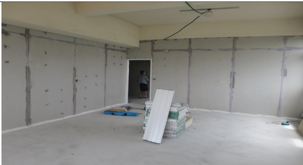
待勤室9mm矽酸鈣板輕隔間 AB 膠填縫批土補平+粉刷水泥漆施工
