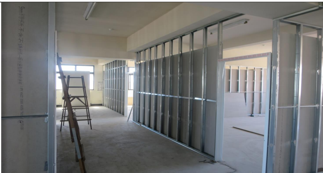
待勤室9mm矽酸鈣板輕隔間+填充隔音岩棉施工
